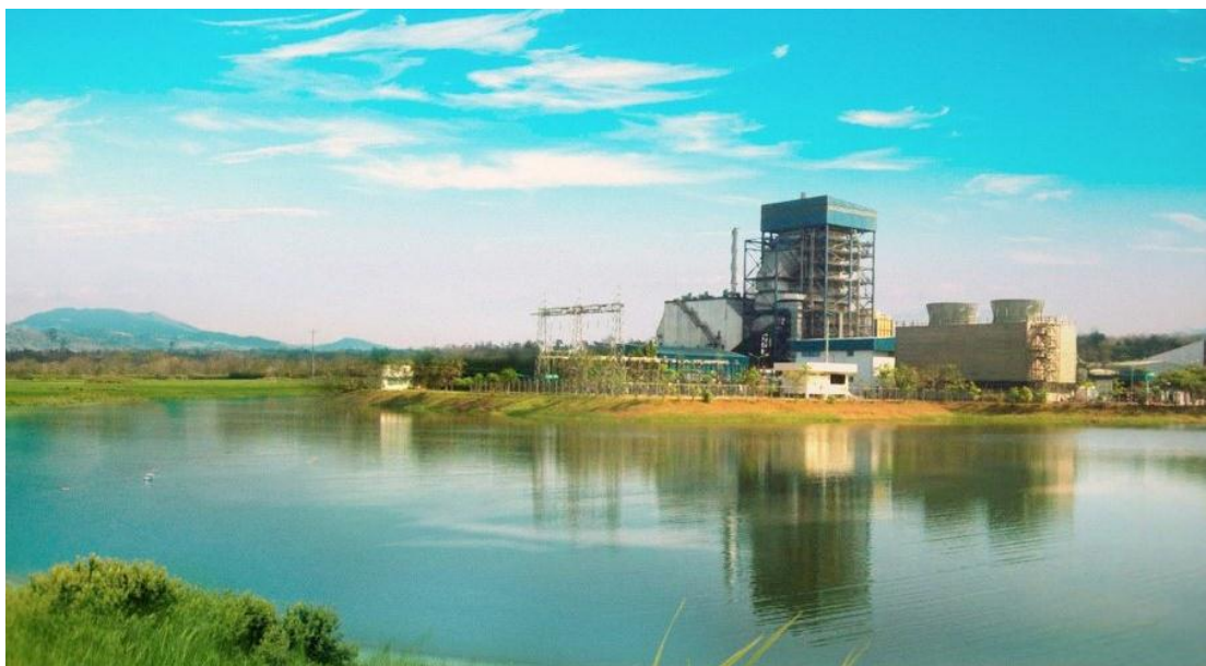
รูปที่ 2.1 โรงไฟฟ้าของบริษัท เอ.ที.ไบโอพาวเวอร์ จำกัด ที่มา: บริษัท เอ.ที.ไบโอพาวเวอร์, โรงไฟฟ้าชีวมวล, เข้าถึงเมื่อ 8 ธันวาคม 2558, เข้าถึงได้จาก http://www.atbiopower.co.th ,
