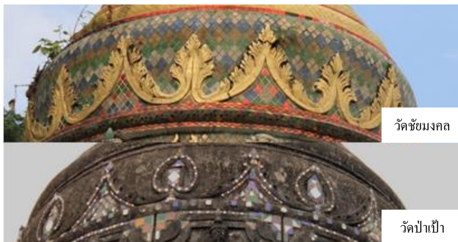
ภาพที่ 42 การประดับลวดลายเหนือรัศมีของวัดชัยมงคลและวัดป่าเป้า จังหวัดเชียงใหม่
