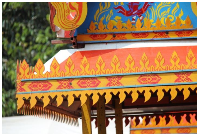
รูปภาพที่ 131 กระจิ่ง หน้ากระดานและกระจิ่งรี (เมรุลอยวัดวังบัว)
