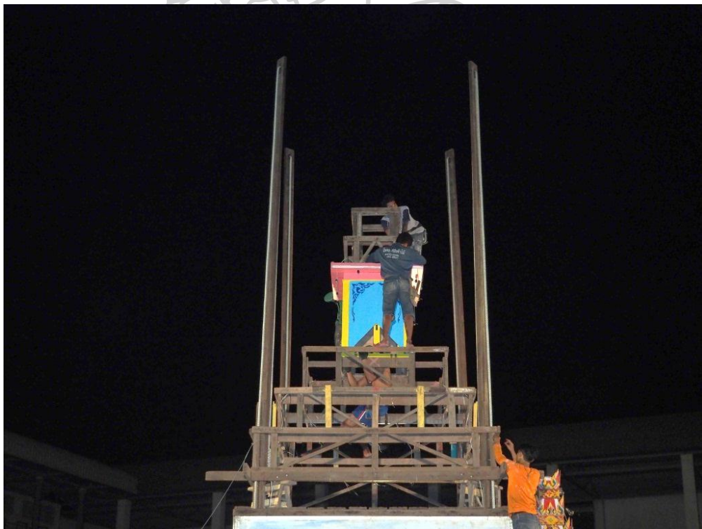
รูปภาพที่ 57 ช่างเริ่มประกอบโครงสร้างของชั้นหลังคา
