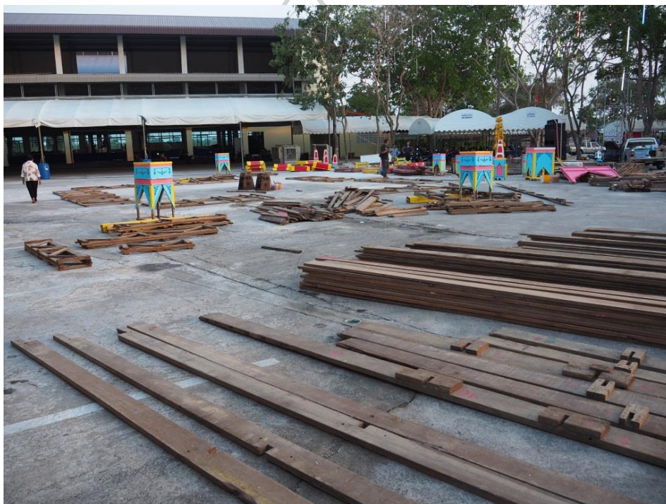
รูปภาพที่ 52 เครื่องประกอบเมรุและรอกที่วางไว้ใกล้จุดที่จะทำการติดตั้ง
