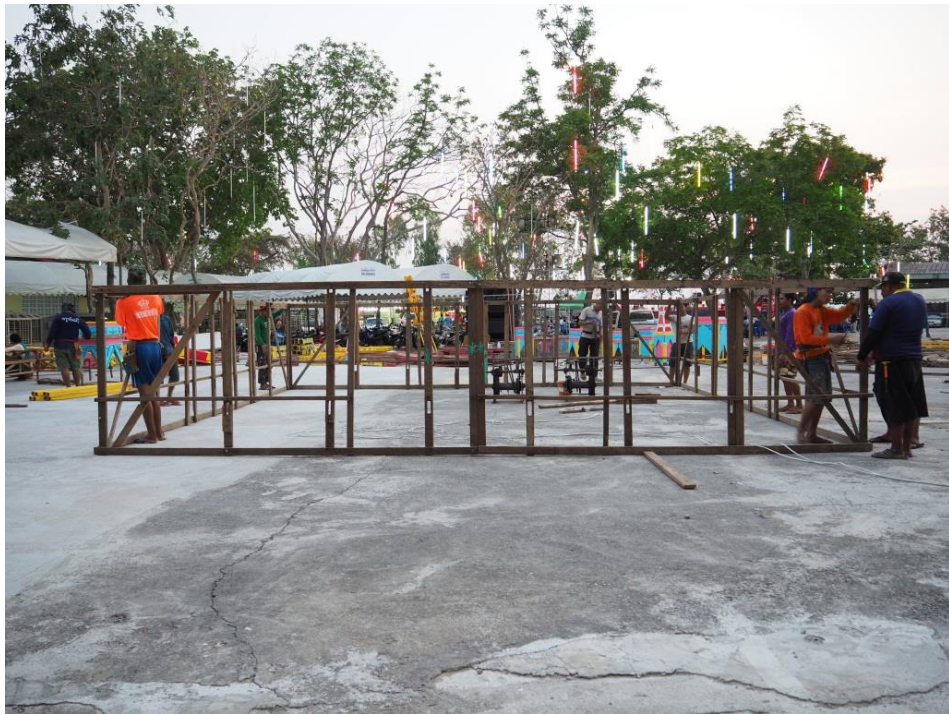
รูปภาพที่ 53 ช่างเริ่มประกอบโครงสร้างส่วนฐาน ชั้นที่ 1
