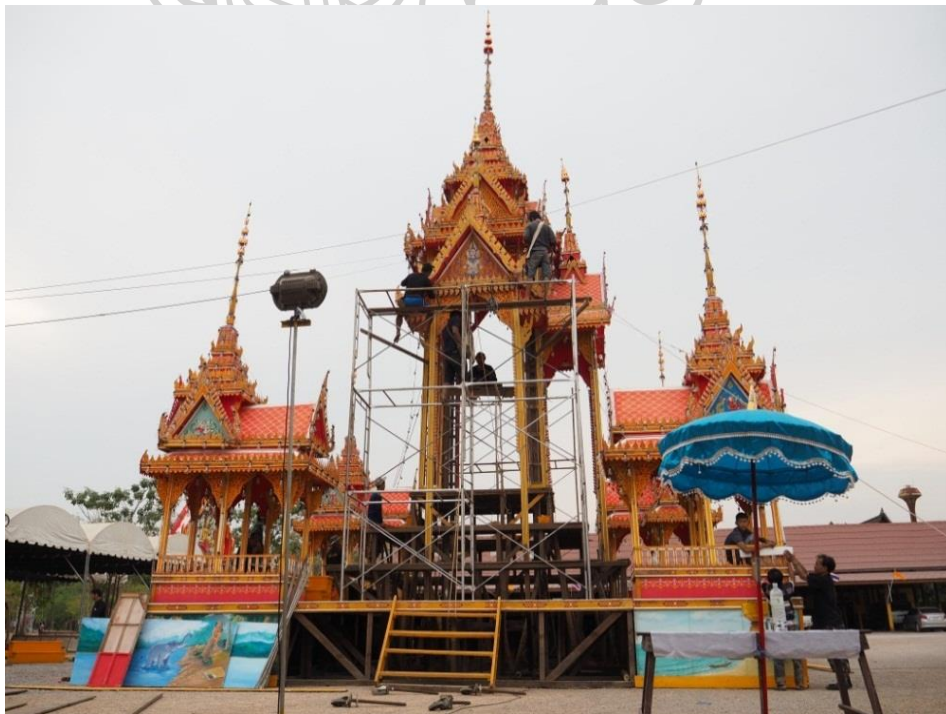
รูปภาพที่ 66 ช่างกำลังประกอบมุขโถง (เมรุलय 9 ยอดโถง วัดเกาะ)
