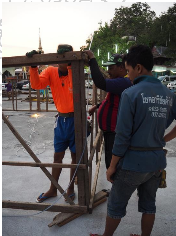
รูปภาพที่ 54 ช่างกำลังวัดระดับโดยใช้สายยางบรรจุน้ำเป็นเครื่องมือในการวัด
