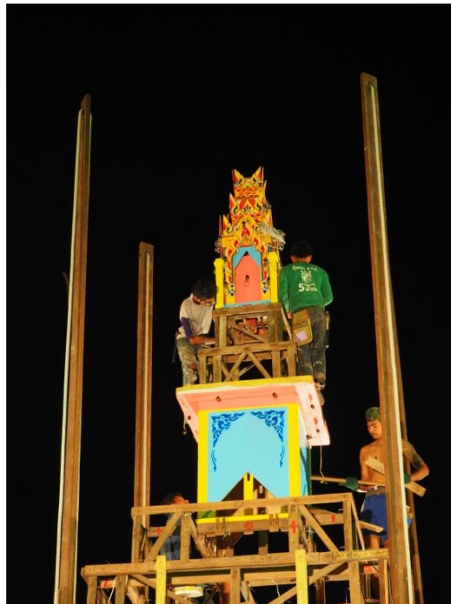
รูปภาพที่ 58 ช่างยกส่วนยอดขึ้นวางเหนือโครงสร้างของชั้นหลังคา
