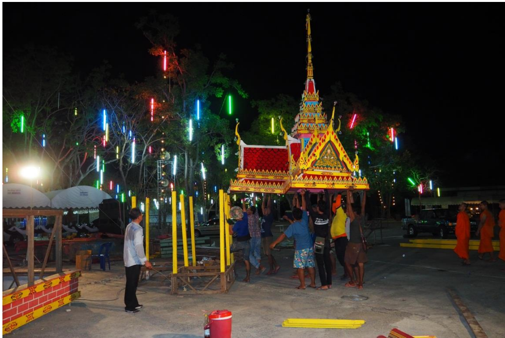
รูปภาพที่ 70 ช่างกำลังยกชั้นหลังคาและส่วนยอดขึ้นวางเหนือตัวเรือนเมรุทิศ
