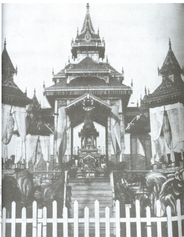
รูปภาพที่ 45 เมรุทรงประยุกต์ แบบอาคารฝรั่ง (ตั้งศพคุณหญิงสุรพันธุ์เส็นี เจียม นุนนาค)
