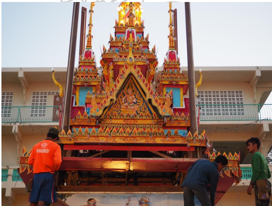
รูปภาพที่ 61 ช่างประดับ กระจก หน้ากระดานและกระจกวิธีชายหลังคา
