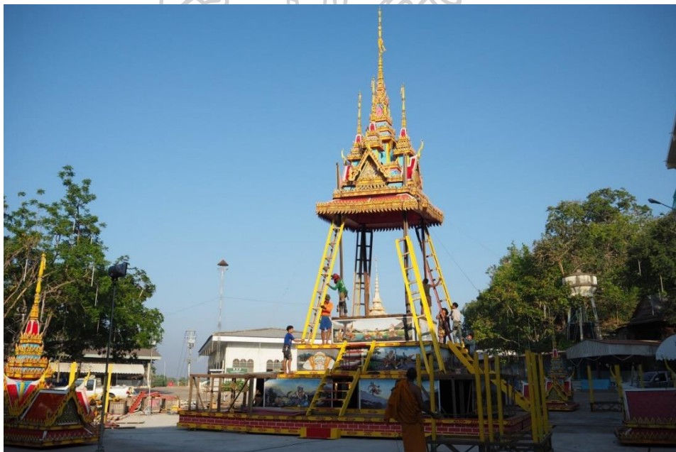
รูปภาพที่ 64 ช่างยกชั้นหลังคาและส่วนยอดขึ้นสู่ตัวเรือนด้านบนสุดและประกอบเสาพราง เพื่อช่วยรองรับน้ำหนัก
