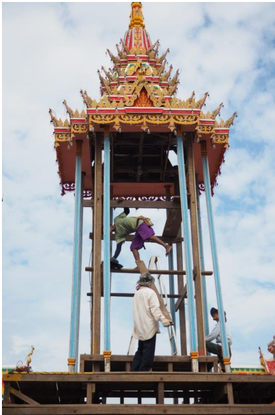
รูปภาพที่ 65 ช่างติดตั้งเสาโถงเพิ่มด้านละ 2 ต้นทั้ง 4 ด้าน เพื่อให้ตัวเรือนอยู่ในผังย่อมุมไม้ 12 (เมรุलयวัดใหญ่สุวรรณารามวรวิหาร)
