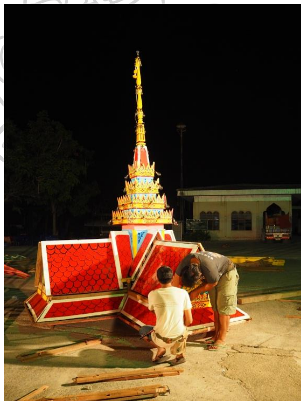
รูปภาพที่ 69 ช่างประกอบชั้นหลังคาและส่วนยอดของเมรุทิศ
