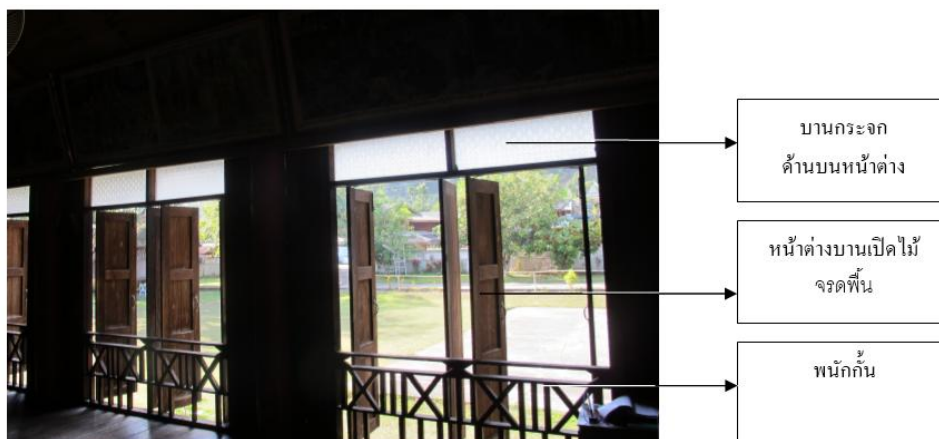
ภาพที่ 72: บานกระจกเหนือบานหน้าต่างส่วนอาคารโถง วัดเมืองปอน จังหวัดแม่ฮ่องสอน เมื่อมองจากด้านในอาคารโถง
