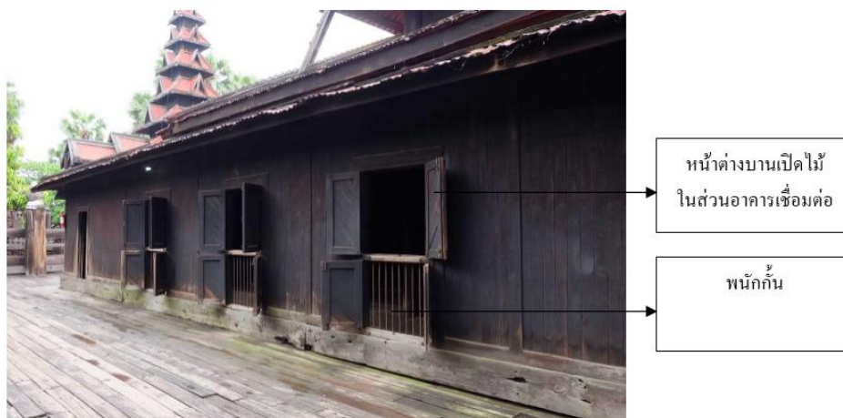
ภาพที่ 68: ภาพหน้าต่างพร้อมพนักกั้นของส่วนอาคารเชื่อมต่อ (sana hsaung) อาคารจองวัดบาคายา เมืองอังวะ
