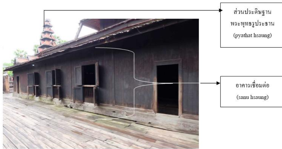
ภาพที่ 49: ภาพแสดงส่วนอาคารเชื่อมต่อ (sanu hsaung) ของวัดบาคายา ที่เมืองอังกอร์
