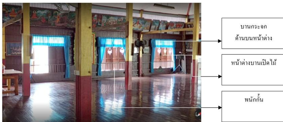
ภาพที่ 70: บานกระจกเหนือบานหน้าต่างและพนักกั้นในส่วนอาคารโถง วัดจงคำ จังหวัดแม่ฮ่องสอน เมื่อมองจากภายในอาคาร
