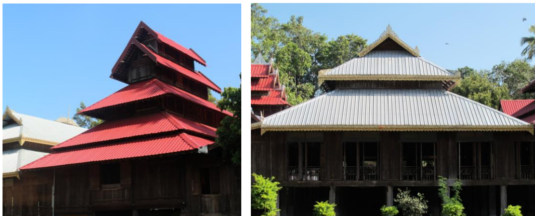
ภาพที่ 37: (ซ้าย) หลังคายกคอสองชั้นขึ้นในส่วนประดิษฐานพระพุทธรูปประธาน วัดเมืองปอน
