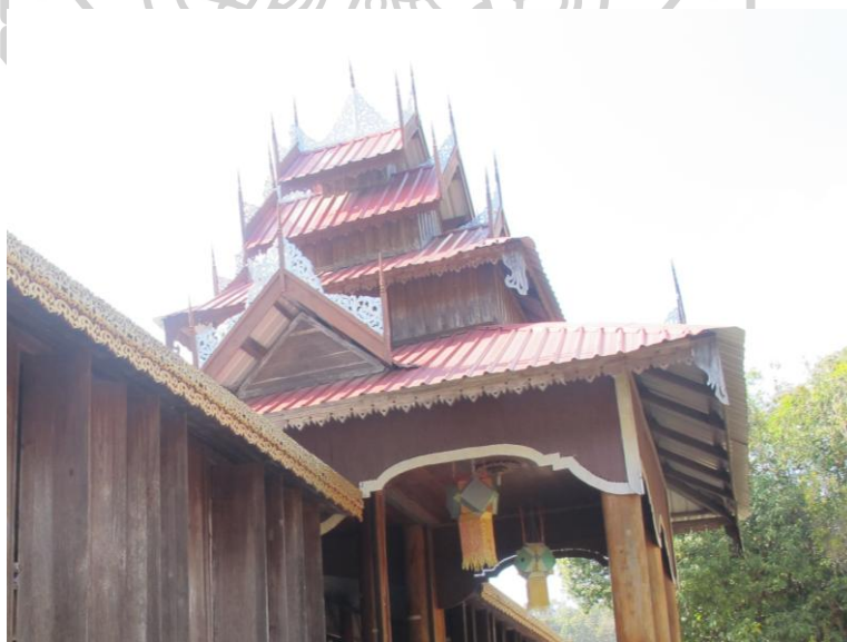
ภาพที่ 39: หลังคาซุ้มทางเข้าอาคารจอง วัดเมืองปอน
