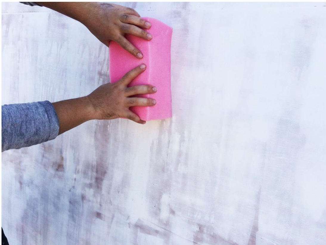
ภาพที่ 6 ภาพขั้นตอนการทำความสะอาดเฟรม ซะล้างฝุ่นผงหลังจากขัดด้วยกระดาษทราย
