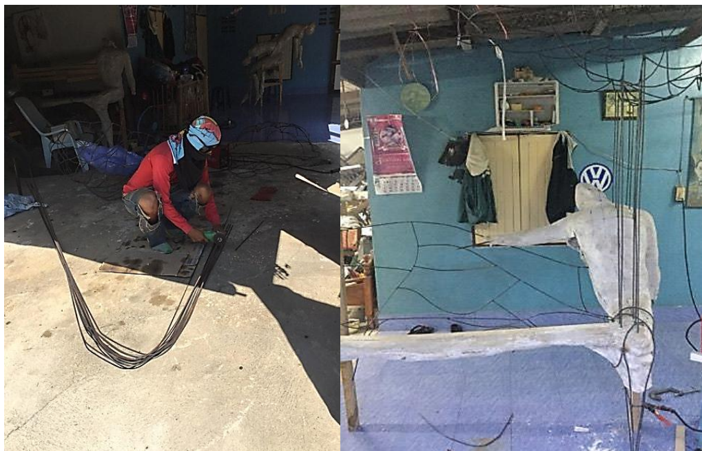
ภาพที่ 36 ขั้นตอนการตัด วัดและประกอบทางด้านโครงสร้างด้านบนวิทยานิพนธ์ ชั้นที่ 3
