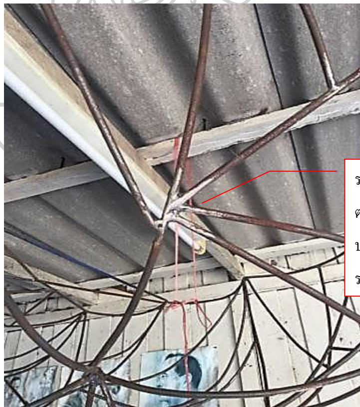
ภาพที่ 26 รอยขัดตรงบริเวณรอยต่อของเหล็กเส้นวิทยานิพนธ์ ชั้นที่ 2
