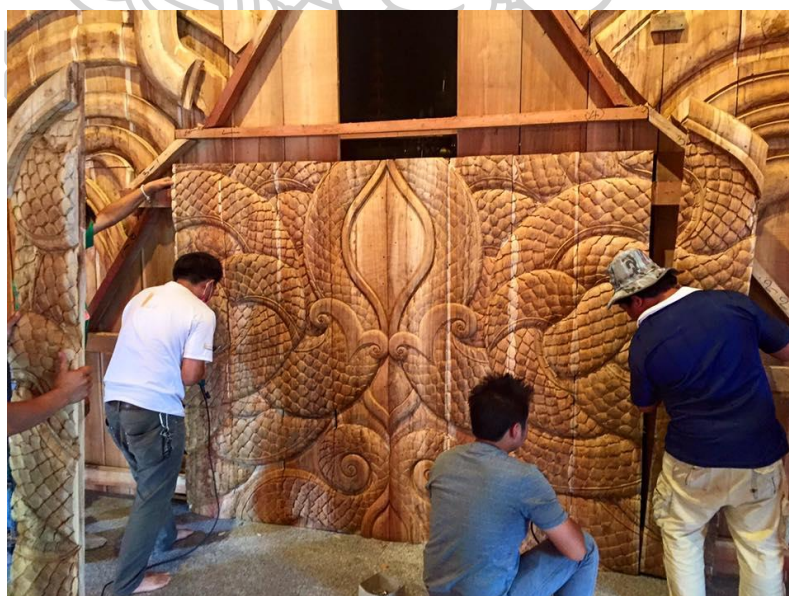
ภาพที่ 163 ถอดชิ้นส่วนเกล็ดพญานาค ลงมาตกแต่งรายละเอียดบนพื้นราบ เพื่อความสะอาดในการทำงาน
