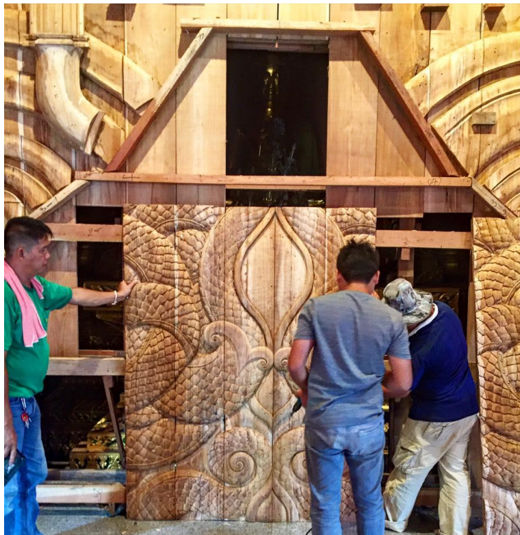
ภาพที่ 162 ถอดชิ้นส่วนเกล็ดพญานาค ลงมาตกแต่งรายละเอียดบนพื้นราบ เพื่อความสะอาดในการทำงาน
