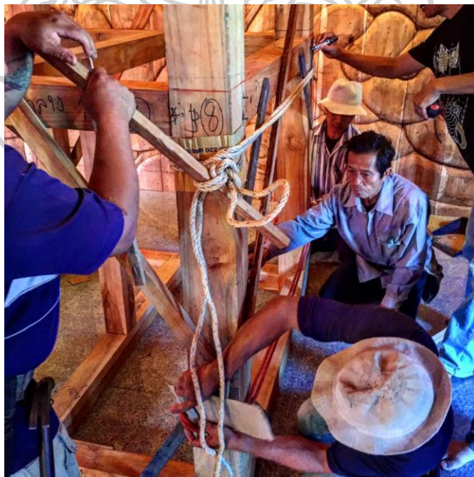
ภาพที่ 136 ทดลองการติดตั้งบุษบกพระประธาน
