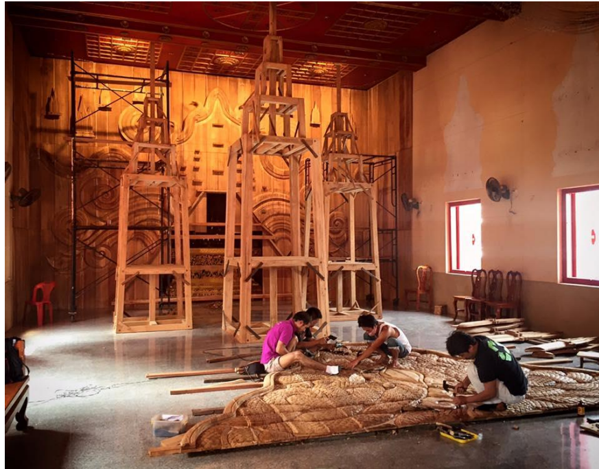
ภาพที่ 164 ถอดชิ้นส่วนเกล็ดพญานาค ลงมาตกแต่งรายละเอียดบนพื้นราบ เพื่อความสะดวกในการทำงาน
