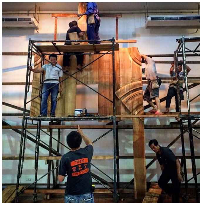
ภาพที่ 184 ขั้นตอนการติดตั้งผลงานที่พิพิธภัณฑ์สถานแห่งชาติ หอศิลป์เจ้าฟ้า
