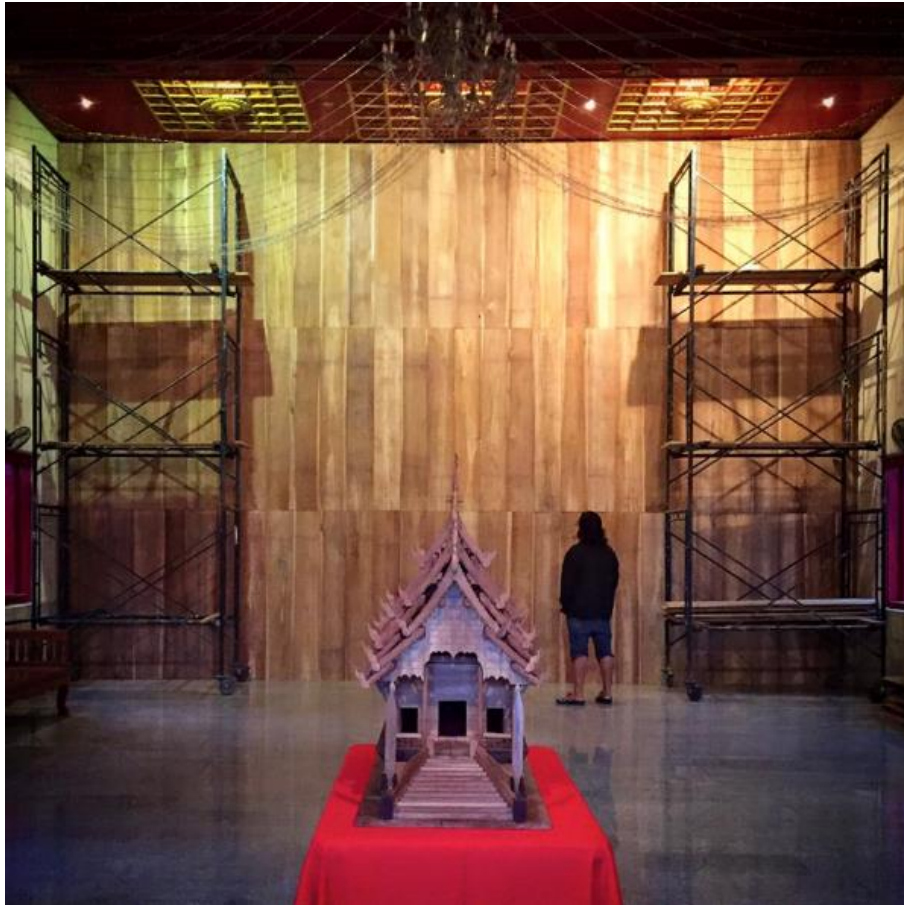
ภาพที่ 110 การติดตั้งแผงไม้สักประกบปิดฐานชุกชีเดิม เตรียมพร้อมทำงานขั้นต่อไป
