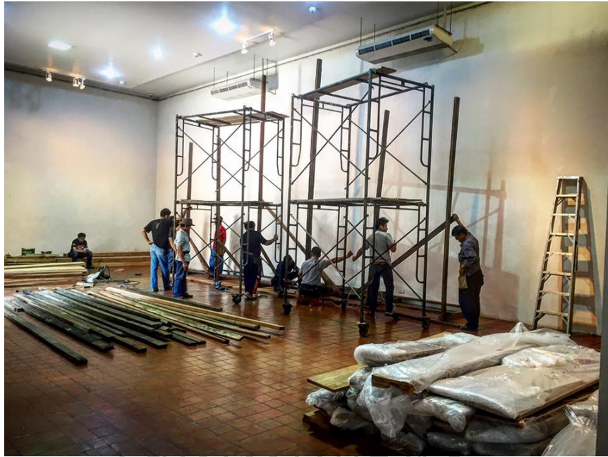
ภาพที่ 180 ขั้นตอนการติดตั้งผลงานที่พิพิธภัณฑ์สถานแห่งชาติ หอศิลป์เจ้าฟ้า
