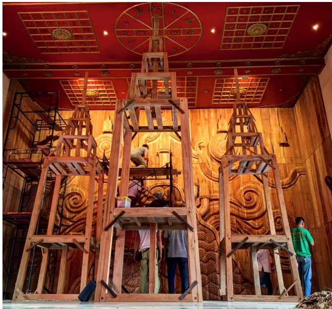
ภาพที่ 150 ทดลองการติดตั้งบุซบก หลังที่ 2 และหลังที่ 3
