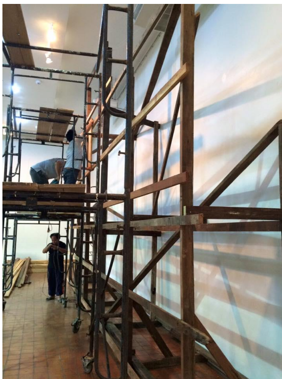
ภาพที่ 182 ขั้นตอนการติดตั้งผลงานที่พิพิธภัณฑ์สถานแห่งชาติ หอศิลป์เจ้าฟ้า
