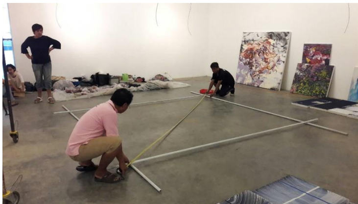
ภาพที่ 67 : การติดตั้งผลงานลอยตัวแบบที่ 2 การต่อโครงอลูมิเนียม
