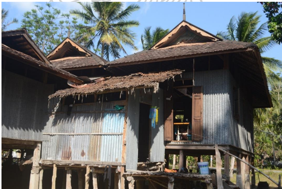
ภาพที่ 3 หลังคามนิลา (บลานอ) ที่มา: แหล่งข้อมูลภาพถ่าย ในเขตหมู่ 2 และ 4 หมู่บ้านภูมิน้ำพุ ตำบลยามู อำเภอยะหริ่ง จังหวัดปัตตานี, ภาพถ่ายเมื่อวันที่ 25 มิถุนายน 2558
