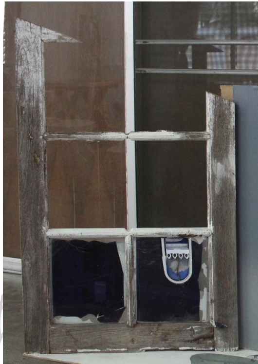
ภาพที่ 12 เตรียมหน้าต่างไม้ที่ได้มีการตัดแต่งไว้แล้วเพื่อมาประกอบเข้ากับตัวงาน
