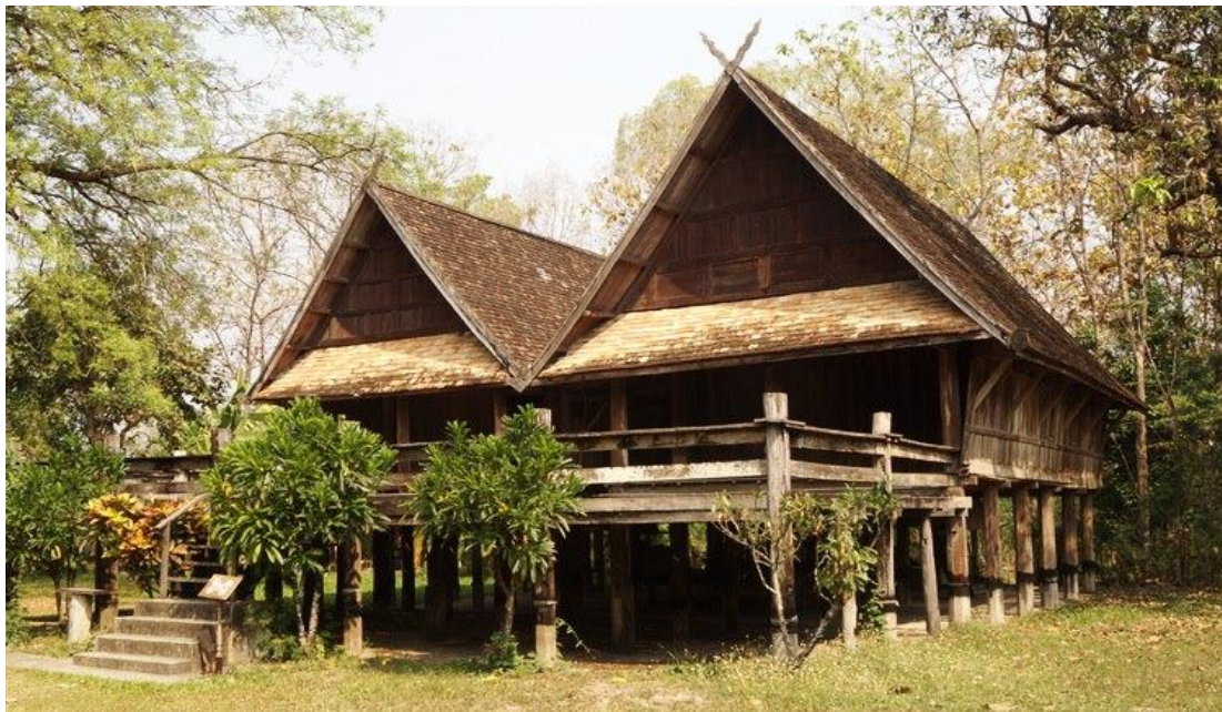
ภาพที่ 3 แสดงตัวอย่างเรือนเครื่องสับ ที่มา : ภาพถ่ายโดยผู้เขียน
