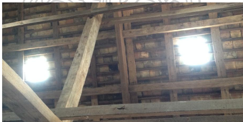
ภาพที่ 87 แสดงบริเวณหลังคาปัจจุบันของเรือนกาแลพญาวงศ์ มีการติดตั้งแผ่นโปร่งแสง
