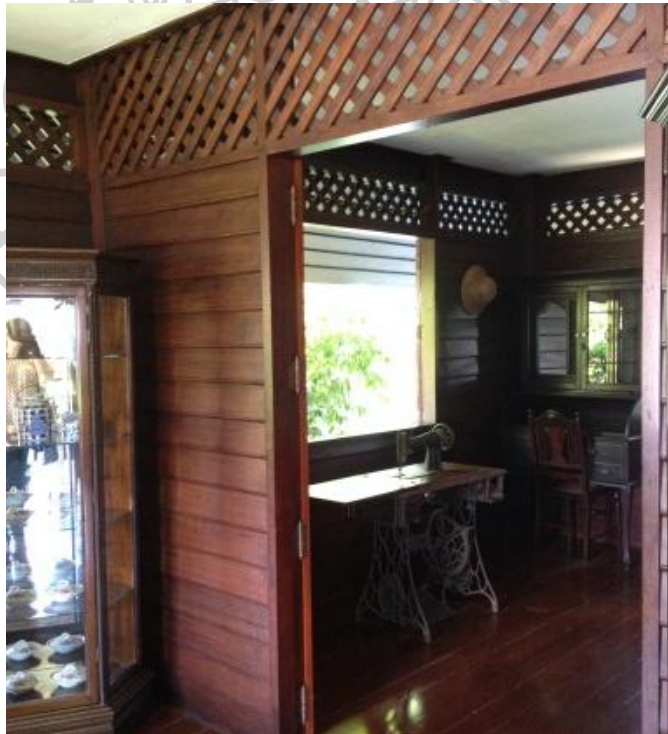
ภาพที่ 68 แสดงช่องลมระหว่างห้องภายในของเรือนไทยพุทธธำมรงค์ บริเวณห้องทำงาน
