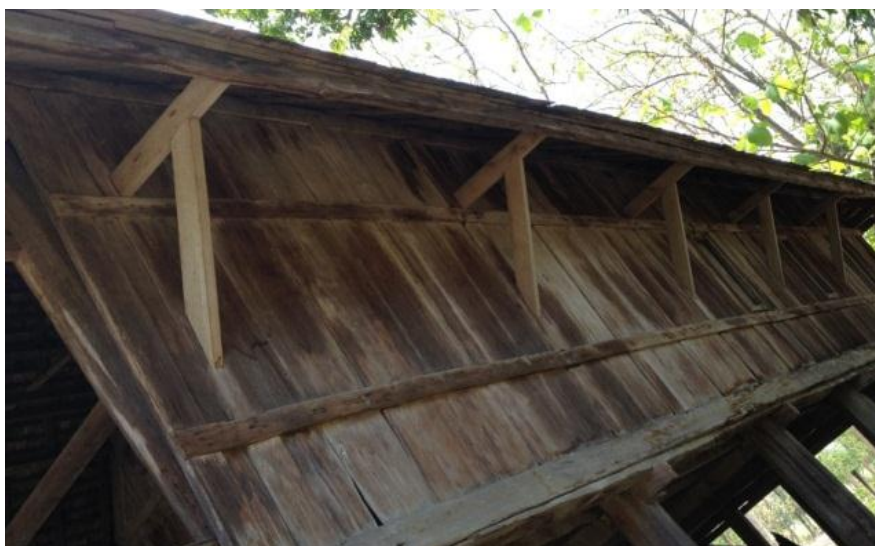
ภาพที่ 46 แสดงผนังเอียงและค้ำยันรองรับหลังคา
