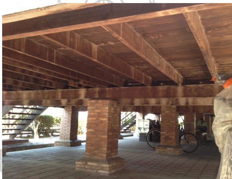
ภาพที่ 60 แสดงระดับยกพื้น และ ฐานเสาก่ออิฐ
