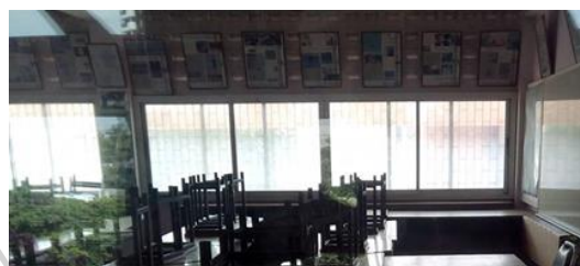
(ง) หน้าต่างบานเลื่อนกระจกในห้องปรับอากาศ
