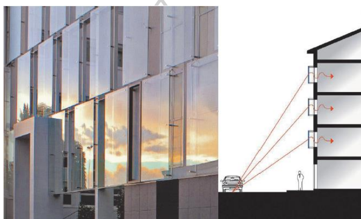
รูปที่ 63 ตัวอย่างการใช้ผนังกระจกกระจกกันเสียงบนโครงสร้างผนังภายนอกของอาคาร (Busa et al., 2011)
