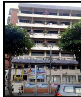
อาคาร 6 มุมมองจากริมถนน
