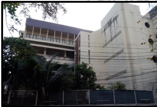
อาคาร 3 มุมมองจากริมถนน
