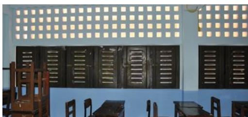
(ค) หน้าต่างบานเหล็กในห้องไม่ปรับอากาศ
