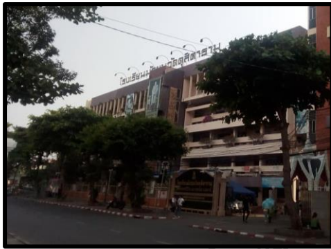
อาคาร 2 มุมมองจากริมถนน
