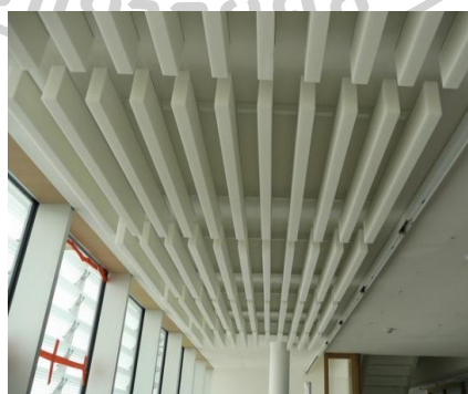
รูปที่ 49 ตัวอย่างการติดตั้งแผงดูดซับเสียงแบบแขวนเพดาน
