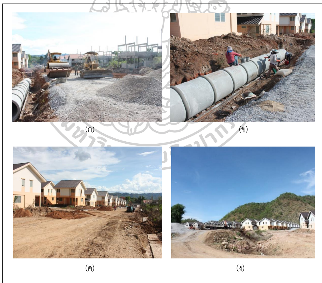
ภาพที่ 15 งานถนน (ROAD A' และ A) และงานท่อระบายน้ำ
