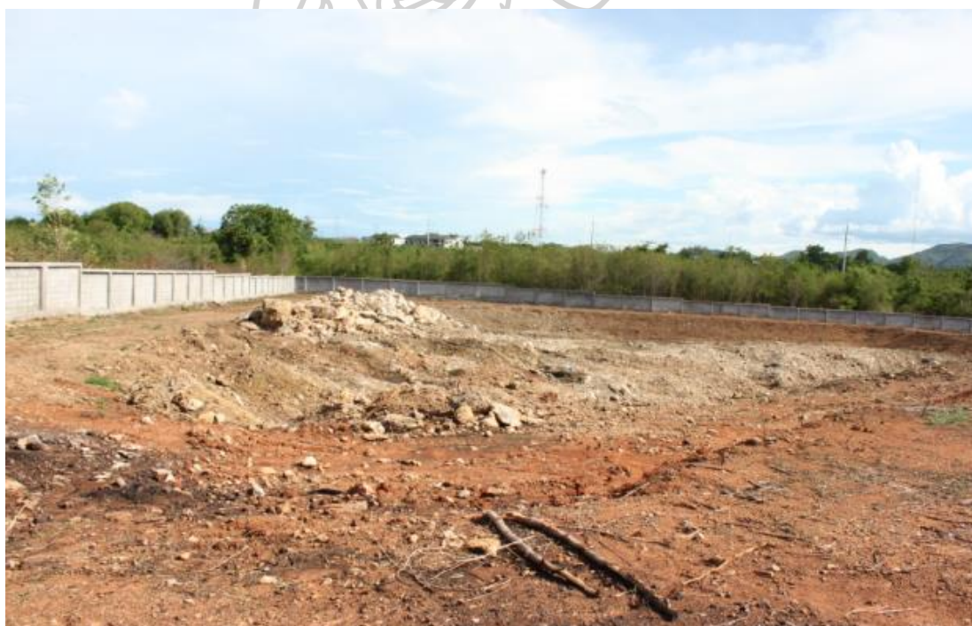
ภาพที่ 17 งานเตรียมพื้นที่บ่อหนองน้ำ และบ่อบำบัด
