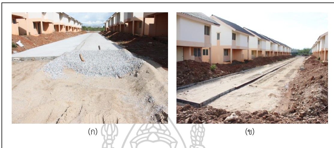
ภาพที่ 16 งานถนน (ROAD C และ D) และงานท่อระบายน้ำ
