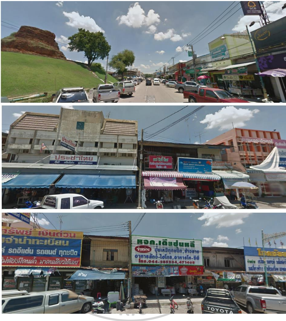
ภาพที่ 34 ภาพอาคารต่างๆในพื้นที่ที่ทำการรื้อถอนสถาปัตยกรรม ในพื้นที่ภูมิทัศน์เมืองประวัติศาสตร์ รีมถนนบุชายันต์
