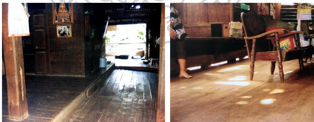
ภาพที่ 108 แสดงบริเวณรอยต่อระหว่างพื้นเต็นและพื้นชานของเรือนชาวยวนลับแล ที่เรียกว่า “แป้นเลียบ” ที่มา : ภาพซ้าย มรกต อาริยะ และพิทักษ์ วัฒนวิทย์กรรม, ภาพขวา สมชาย ปงศรีชัย (อ้างใน ศิริวรรณ วิบูลย์มา และคณะ, 2552)
