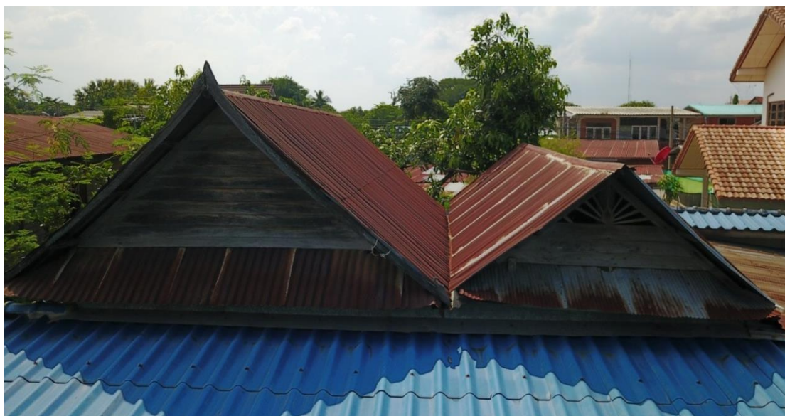
ภาพที่ ข-1 แสดงลักษณะหน้าจั่วและไม้ปั้นลมของเรือนกรณีศึกษาที่ 6 (ไม้ปั้นลมของจั่วเล็กหลุดออกไปแล้ว)
