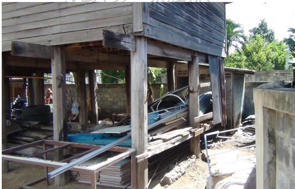
ภาพที่ ก-6 แสดงเทคนิคเสาดั้งของเรือนกรณีศึกษาที่ 1 (เป็นเสาดั้งวางคร่อมบนรอดและมีเสาทอม่อรองรับรอด) ส่วนรอดที่ยื่นยาวออกมาจากเสาด้านในของเรือนนอน ใช้สำหรับรองรับแผ่นไม้กระดานของส่วน “แป้นเลียบ”
