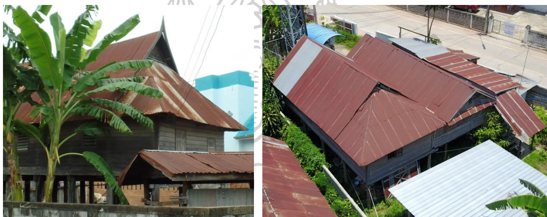
ภาพที่ 52 แสดงเรือนกรณีศึกษาที่ 1 และ 4 ที่มีหลังคาทรงจั่วทำหลังคาปีกนกขนาดใหญ่คลุมพื้นที่ 1 ช่วงเสาด้านหน้า
