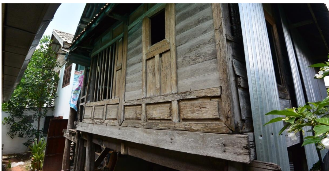
ภาพที่ 61 แสดง “ฝาประกอบสำเร็จ” ของเรือนนางลง สมใจเพ็ง ที่ชุมชนบ้านเหนือ (เรือนอายุประมาณ 100 ปี)
