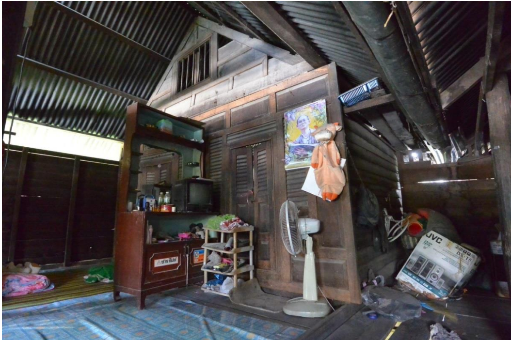
ภาพที่ ก-17 แสดงลักษณะฝาผนังระหว่างเดินและในเฮือน (แหนบเต็น) ของเรือนกรณีศึกษาที่ 4
