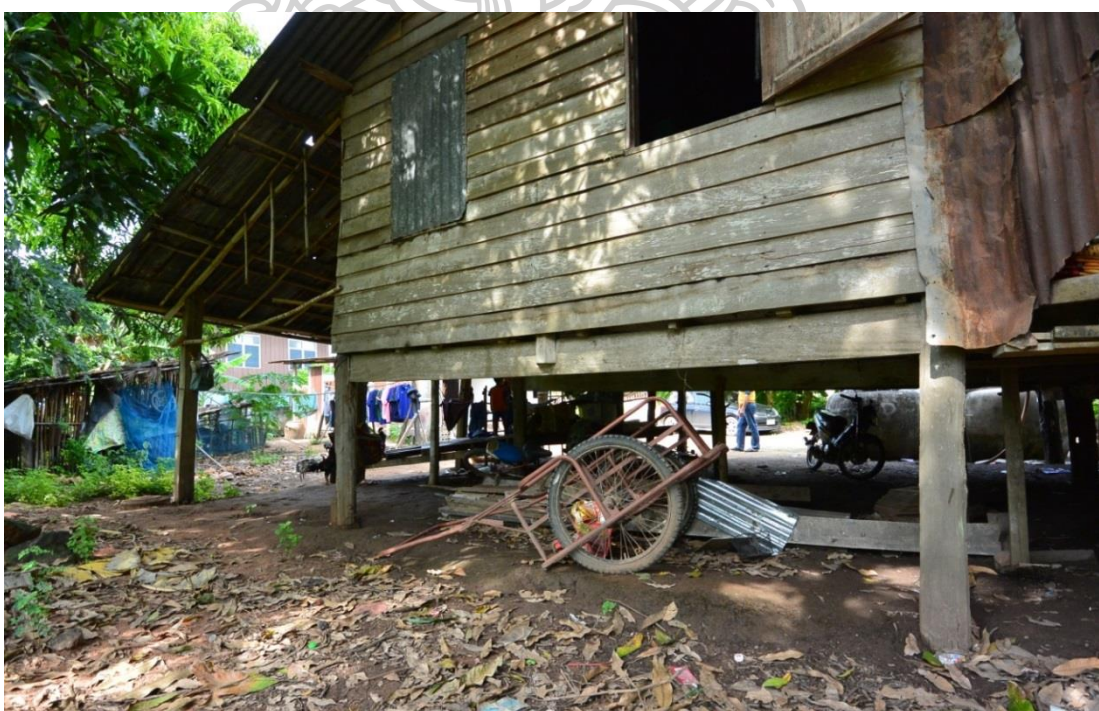
ภาพที่ ข-12 แสดงเทคนิคเสาดั้งคร่อมบนรอดจากมุมมองด้านหลังของเรือนกรณีศึกษาที่ 8 (ได้ถุนเรือนเคยสูงกวานี้ แต่ที่ดินรอบๆ ได้ถมที่สูงขึ้นจนทำให้บริเวณนี้กลายเป็นแอ่งที่มีตะกอนดินไหลลงมาทับถม)
