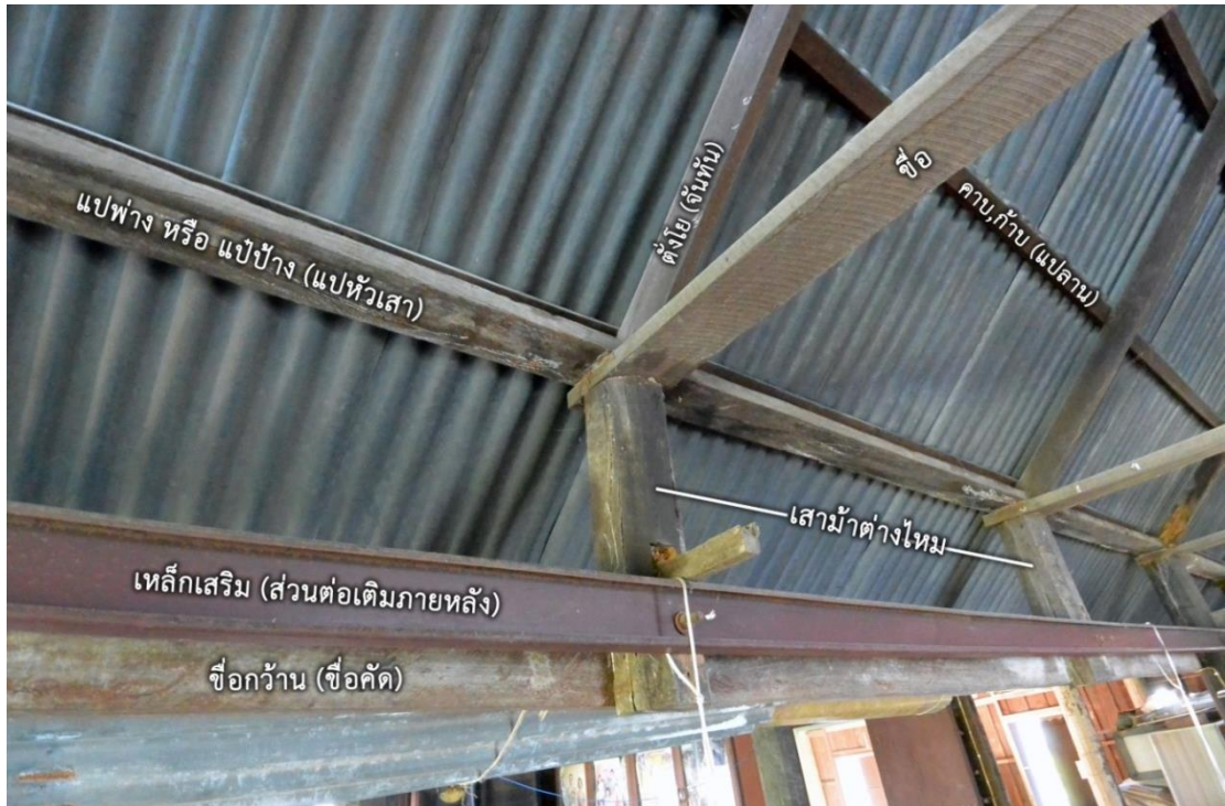
ภาพที่ 80 แสดงเทคนิคการใช้ “เสาไม้ต่างไหม” ที่พบในโครงสร้างเครื่องบนของเรือนกรณีศึกษาที่ 7
