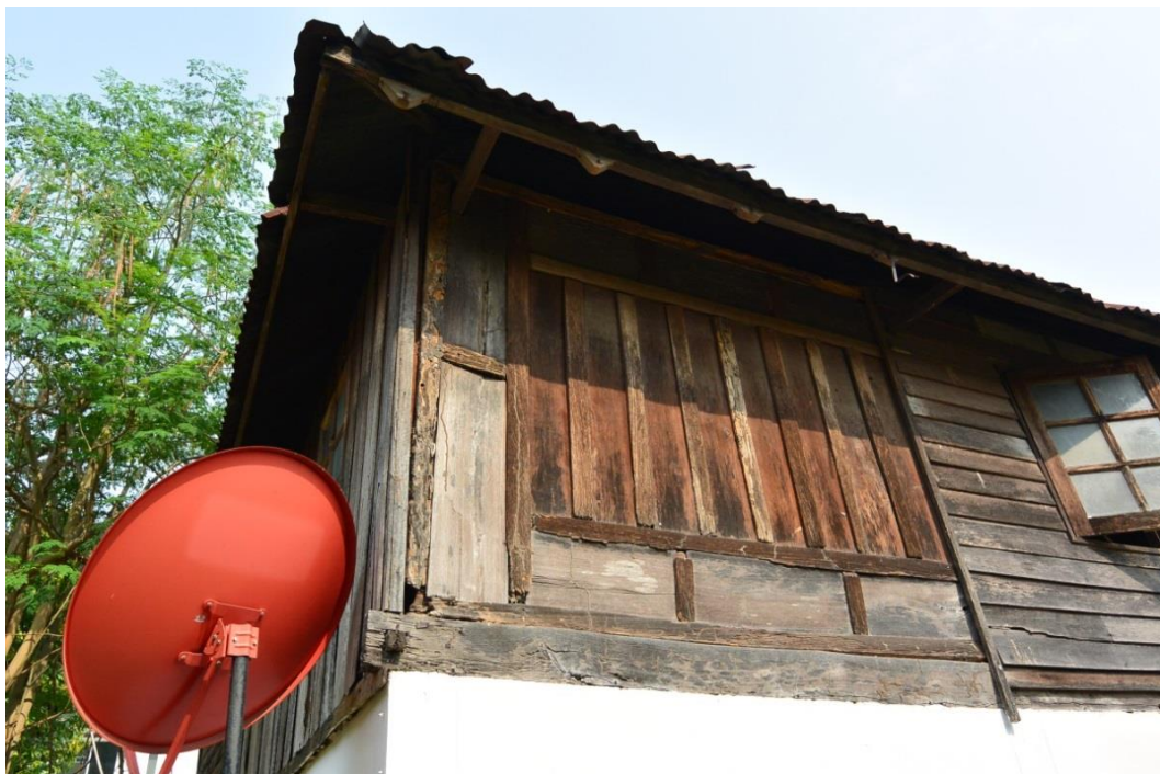
ภาพที่ ก-15 แสดงร่องรอยการใช้ไฟฟ้าประกอบสำเร็จของเรือนกรณีศึกษาที่ 3 (ฝาเรือนนอนด้านทิศตะวันออก)
