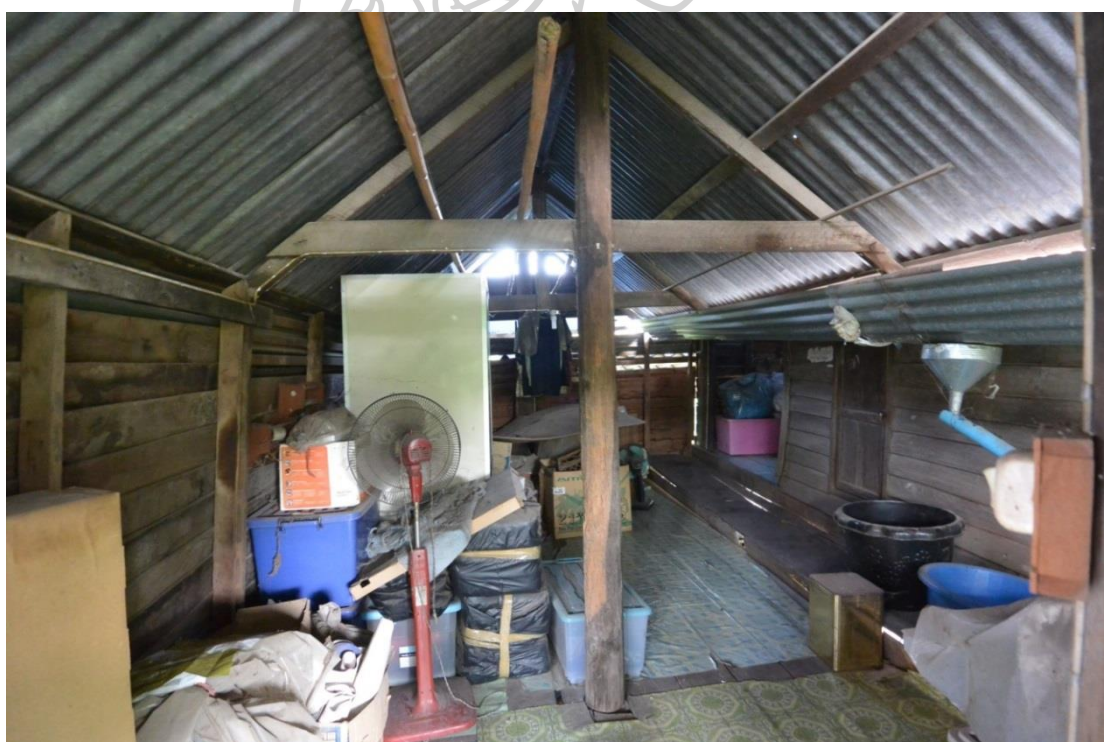
ภาพที่ ข-2 แสดงเสาดั้งรับโครงหลังคาเรือนโถงของเรือนกรณีศึกษาที่ 6 (มุมมองจากด้านทิศตะวันตก-ท้ายเรือน)
