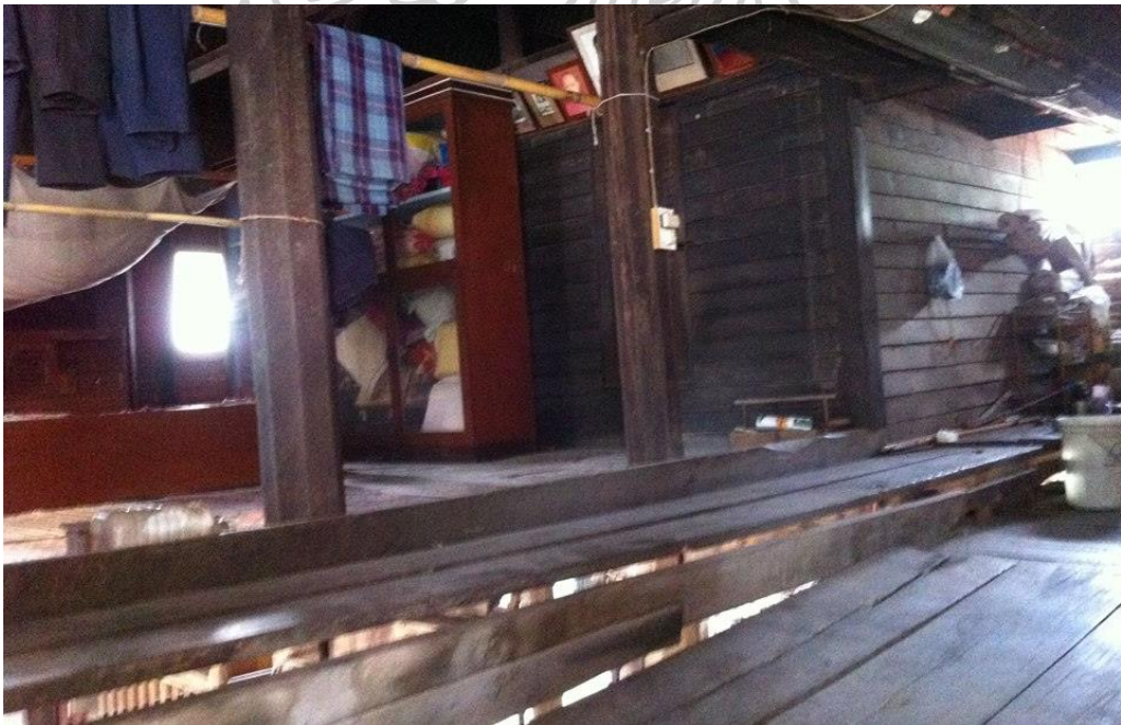
ภาพที่ ก-2 แสดง “เบ้นเลียบ” อยู่ระหว่างเรือนประธาน (ด้านซ้าย) และเรือนโถง (ด้านขวา) ของเรือนกรณีศึกษาที่ 1
