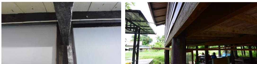
ภาพที่ 88 ลักษณะ “รอดสอดเสา” ในเรือนกรณีศึกษาที่ 12 (ชาย) และ “คานทาบเสา” ในเรือนกรณีศึกษาที่ 13 (ขวา)
