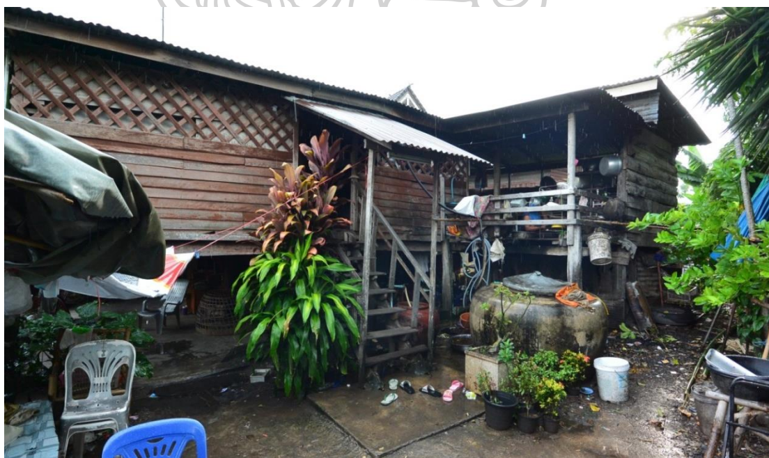
ภาพที่ ค-2 แสดงส่วนครัวของเรือนกรณีศึกษาที่ 10 (ด้านขวา) ที่ต่อเติมจากชานออกไปด้านข้าง ภายใต้ข้อจำกัดของที่ดิน
