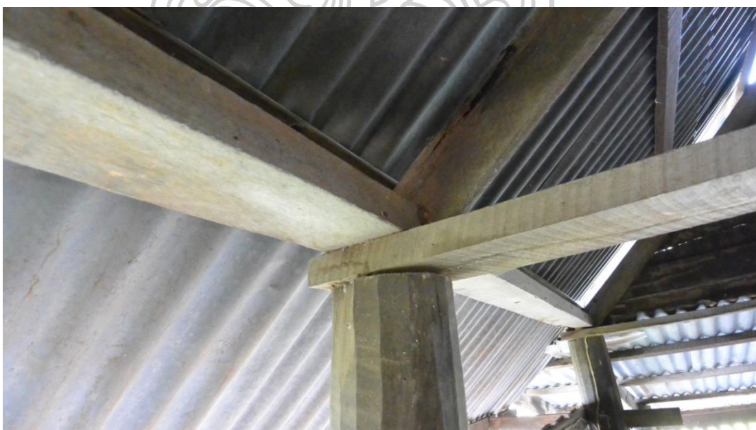
ภาพที่ ข-6 แสดงเทคนิคการเข้าไม้แบบดั้งเดิมของเรือนกรณีศึกษาที่ 7 (ซื่อและแปสวมกับหัวเทียนที่ปลายเสา)
