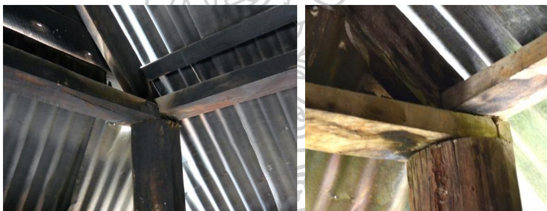
ภาพที่ 46 ลักษณะของเสาเรือนหน้าตัดแปดเหลี่ยม และการวางแปหัวเสาและช่อร้อยกับหัวเทียนที่ศูนย์กลางเสา
