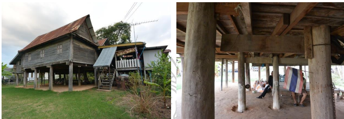
ภาพที่ 102 แสดงเรือนของชาวไทโคราช (บ้านบุงลำไย) ที่ใช้ระบบโครงสร้างแบบ “เรือนสองหลังร่วมพื้น”
