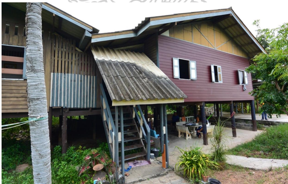
ภาพที่ ค-8 แสดงมุมมองด้านหน้าของเรือนกรณีศึกษาที่ 13 (ใช้บันไดช่วงเดียวมีหลังคาคลุมและขึ้นเรือนจากด้านหน้าจั่ว)
