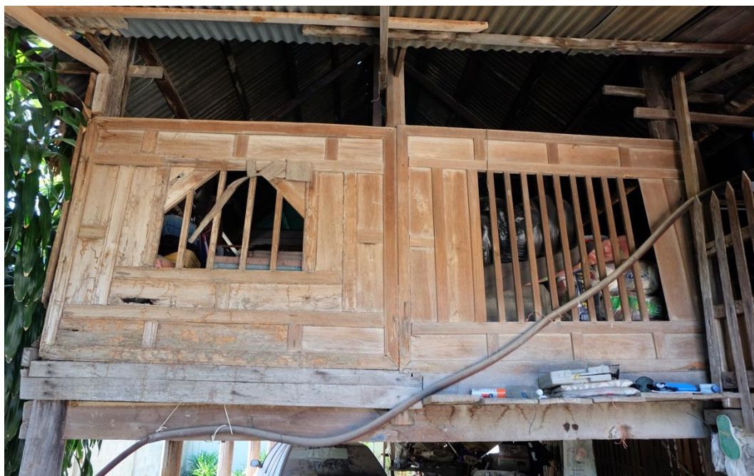
ภาพที่ ก-21 แสดงลักษณะฝาประกอบสำเร็จของเรือนกรณีศึกษาที่ 5 (ฝาด้านสกัดส่วนหน้าของเรือนประธาน)
