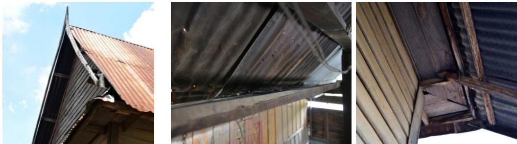
ภาพที่ 65 ปั้นลมแบบตัวเหงา ภาพที่ 66 “ควั่น” มุมมองจากภายใน (ซ้าย) และภายนอกเรือน (ขวา)
