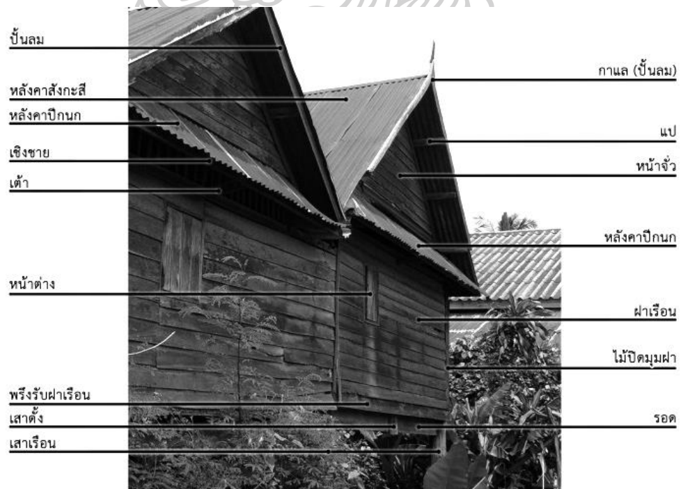
ภาพที่ 44 แสดงส่วนประกอบและเทคนิคก่อสร้างของเรือนกรณีศึกษาที่ 4 (มุมมองด้านสกัดข้าง หลังเรือน)
