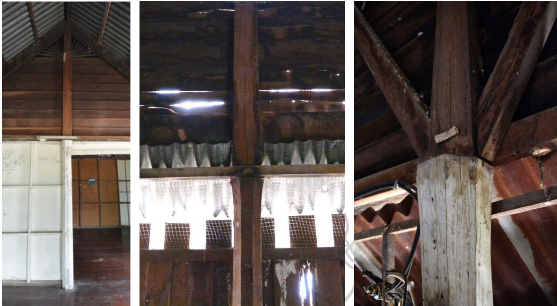
ภาพที่ 67 ตัวอย่างการเหลาตกแต่งเสาดั้ง (โดยทั่วไปจะมีส่วนบนของเสาสอบเล็กและปลายเสาบานออก)
