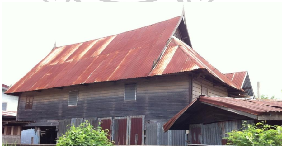
ภาพที่ 23 แสดงรูปทรงหลังคาไม้ปั้นลมแบบมีตัวเหงา และฝาเรือนรุ่นหลังที่ทำเป็นฝาไม้กระดานตีเกล็ด (บริเวณบ้านใต้) ที่มา : อนุเคราะห์ภาพโดย นางสุธัญญา สิทธิกุลเกียรติ, ถ่ายเมื่อประมาณปี พ.ศ.2553
