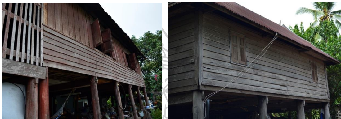
ภาพที่ 79 แสดงตัวอย่างฝาเรือนแผ่นไม้ตีกับโครงเคร่า และหลังคามุงด้วยสังกะสี ของเรือนกรณีศึกษากลุ่ม B
