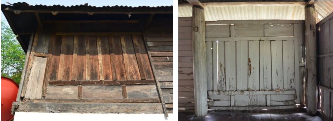
ภาพที่ 59 แสดงร่องรอยการใช้ไฟฟ้าเรือนที่คล้ายกับฝาปะกนผสมฝาสายบัววางบนพริ้ง ในเรือนกรณีศึกษาที่ 3
