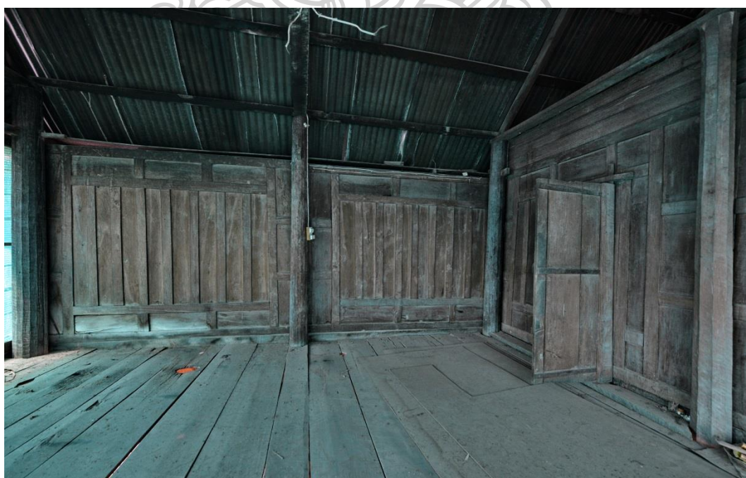
ภาพที่ ก-22 แสดงลักษณะฝาประกอบสำเร็จ (ลักษณะคล้ายฝาปะกนผสมฝาสายบัว)
