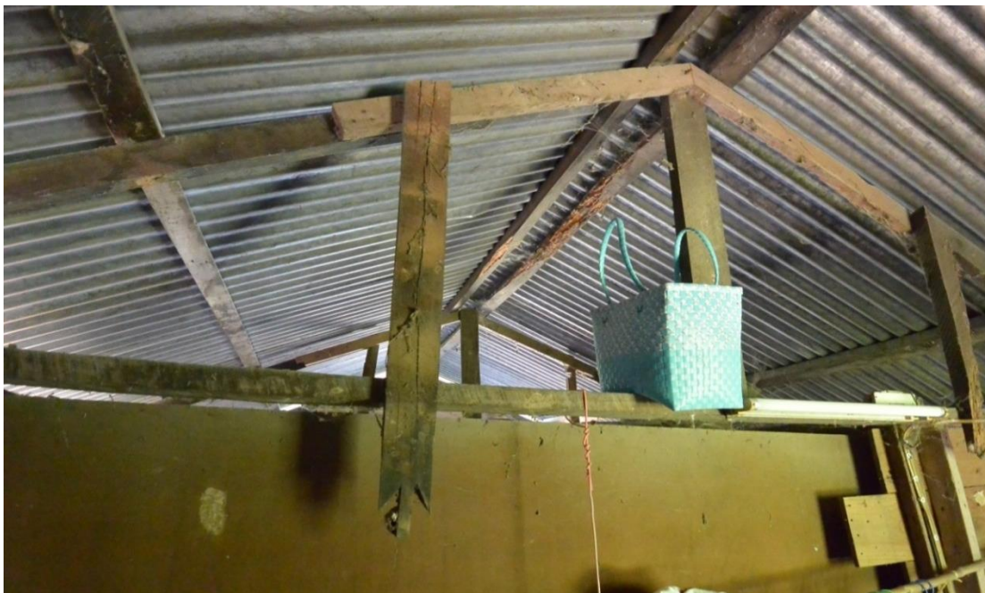
ภาพที่ ข-9 แสดงร่องรอยใบดั้งเดิมของเรือนกรณีศึกษาที่ 8 ซึ่งถูกรื้อและนำไม้มาใช้เป็นส่วนประกอบของหลังคาที่ใหม่
