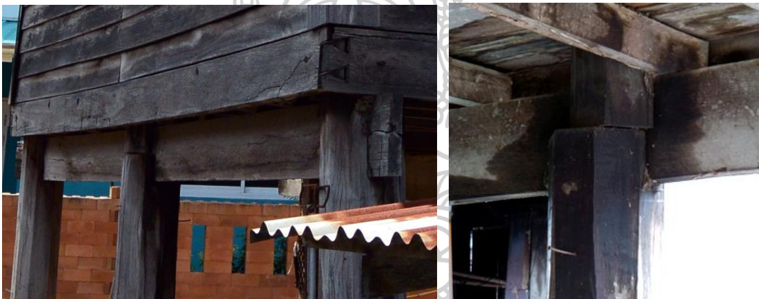
ภาพที่ 50 ลักษณะของ “เสาดั้งวางบนรอดซึ่งมีเสาทอม่อรับ (ตุ้คล้ายกับต่อเสา)” ที่พบในเรือนกรณีศึกษาที่ 1
