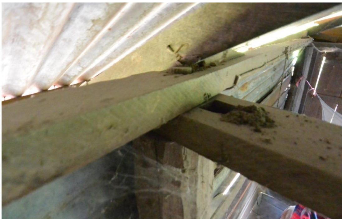
ภาพที่ ข-11 แสดงเทคนิคการเข้าไม้แบบดั้งเดิมของเรือนกรณีศึกษาที่ 8 (ข้อและแปสวมกับหัวเทียนที่ปลายเสา)
