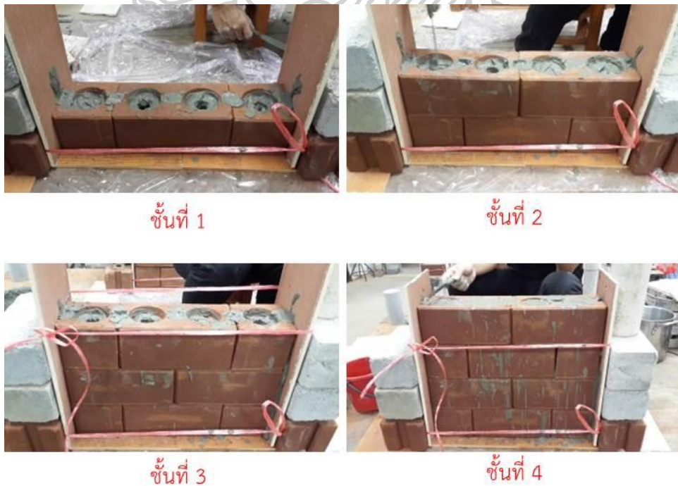
ภาพที่ 44 แสดงภาพขั้นตอนการนำส่วนผสมไปหยอดรูบล็อกประสานทีละชั้น และประกอบบล็อกเข้าหากัน
