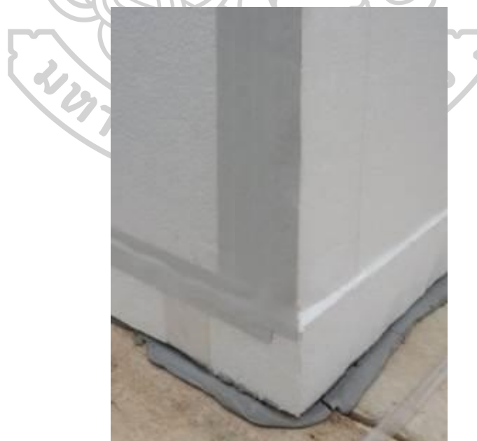
ภาพที่ 57 แสดงภาพขั้นตอนการอุดรอยต่อด้วยซิลิโคน และปิดทับด้วยเทปผ้าสีขาว
