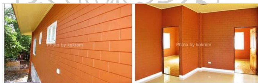
ภาพที่ 7 แสดงภาพรูปแบบผนังบล็อกประสาน
