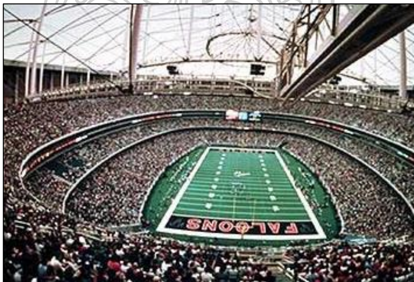
ภาพที่ 20 Georgia Dome by Levy and Weidlinger Associates
