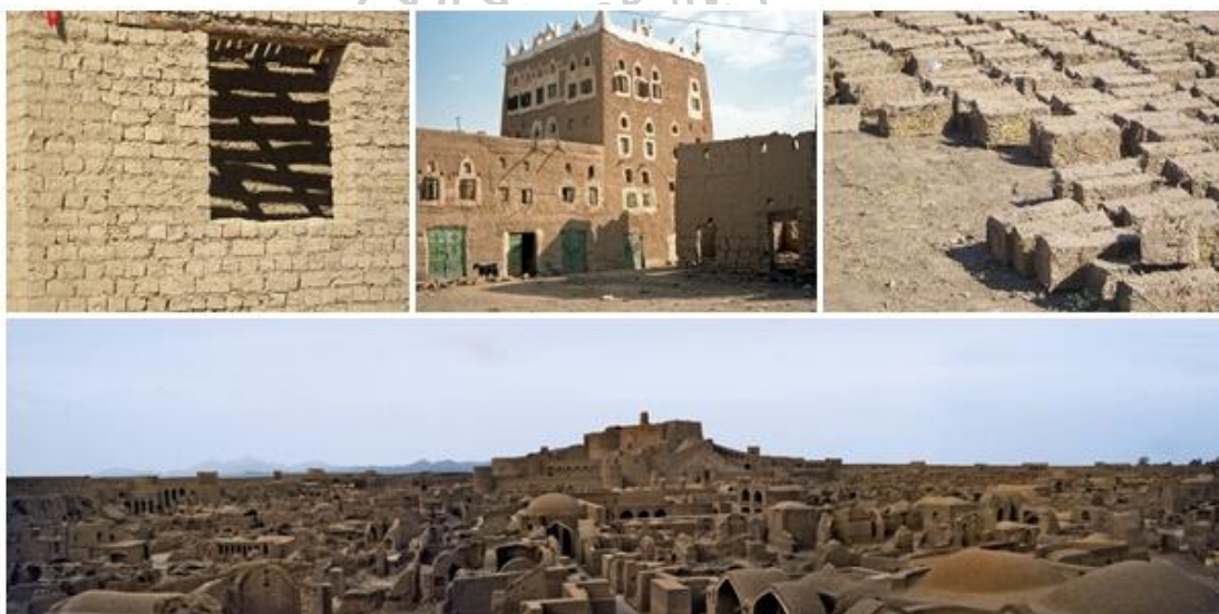
ภาพที่ 2 ที่อยู่อาศัยที่สร้างขึ้นจากวัสดุอินทรีย์ (organic materials.) หรือ Adobe
