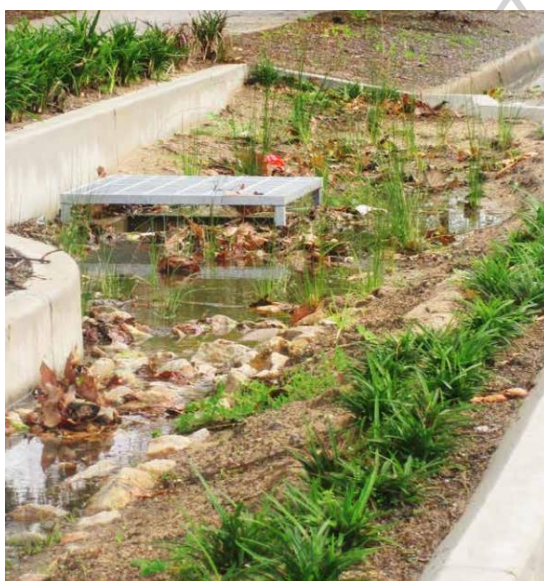
ภาพที่ 7 ตัวอย่างพื้นที่พื้นที่หนองน้ำชีวภาพ ที่มา: WSUD-WA (Department of Planning and Local Government: Government of South Australia, 2010)
