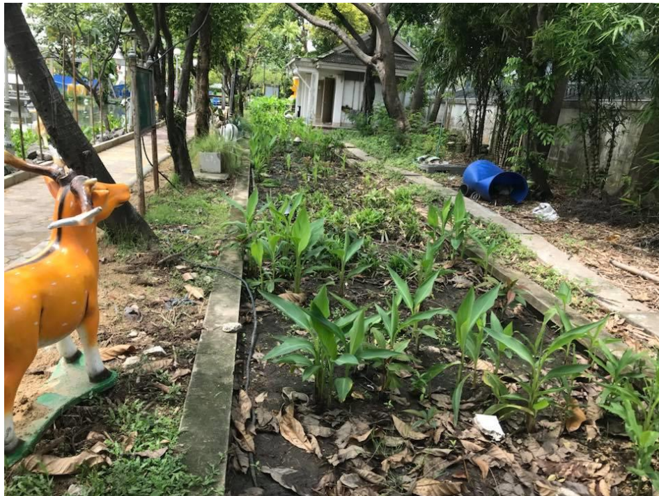
ภาพที่ 54 แสดงระบบพืชและหญ้ากรองน้ำเสียของวัดพระรามเก้า กาญจนนาภิเษก ในปัจจุบัน ที่มา: จากการสำรวจ
