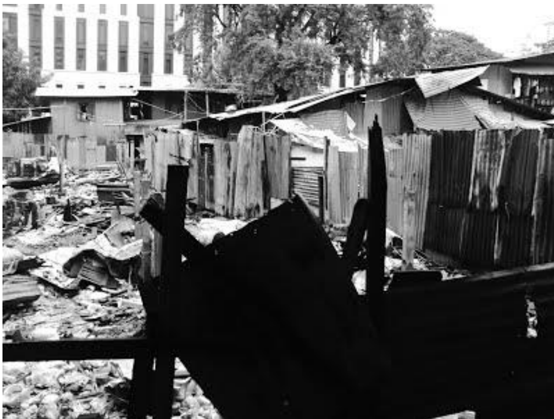
ภาพที่ 27 แสดงสภาพอาคารภายในชุมชน
