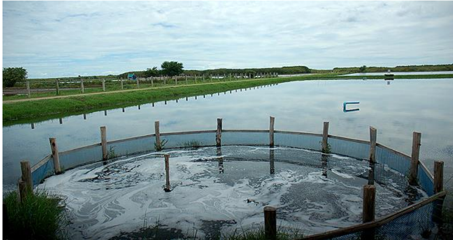
ภาพที่ 33 แสดงระบบบำบัดน้ำเสีย
