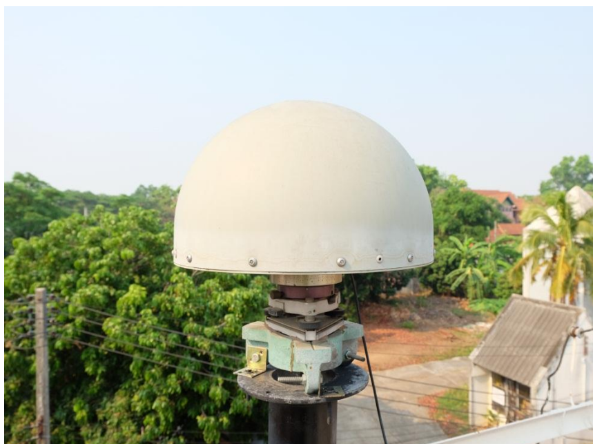
รูปที่ 2.21 จานรับสัญญาณดาวเทียม GPS ที่ศูนย์อุตุนิยมวิทยาภาคเหนือ จังหวัดเชียงใหม่
