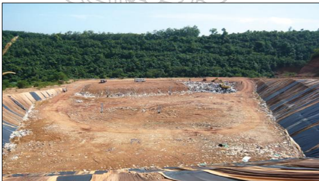
รูปที่ 2.4 วิธีฝังกลบแบบหุบเขา (Canyon method)
