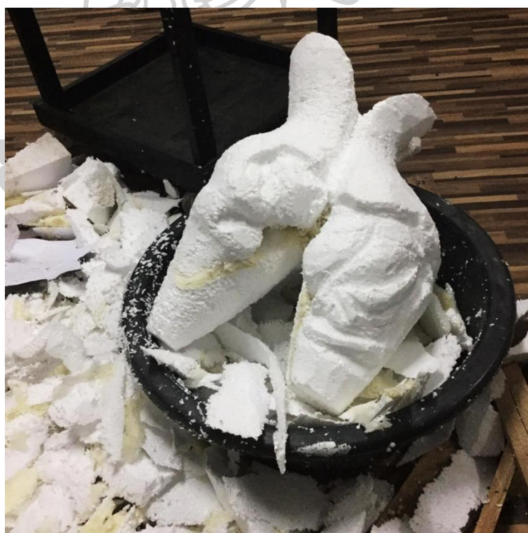
ภาพที่ 21 ภาพการขึ้นโครงสร้างหลักด้วยโฟมก่อน
