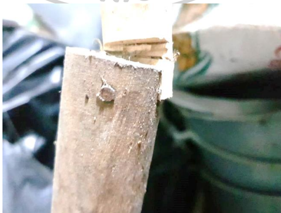
ภาพที่ 212 การประกอบไม้โดยการใช้ตะปูเป็นเดือย ในผลงาน “เครื่องมือ 1”
