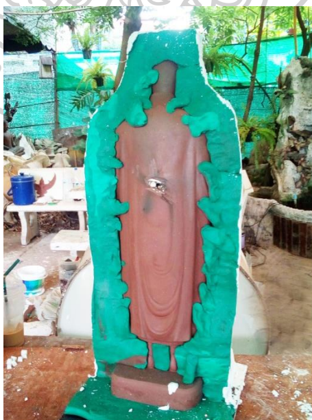
ภาพที่ 48 ตัดเหล็กโครงสร้างออก
