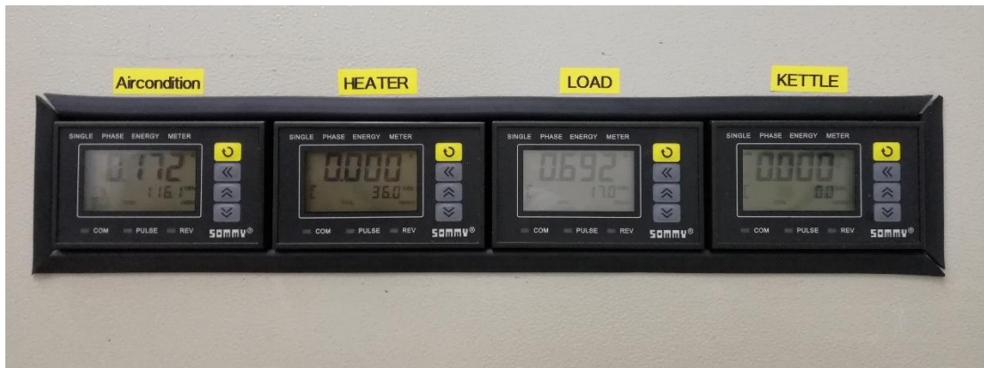
รูปที่ 3.21 อุปกรณ์วัดการใช้พลังงานของห้องทดลองที่ 1
