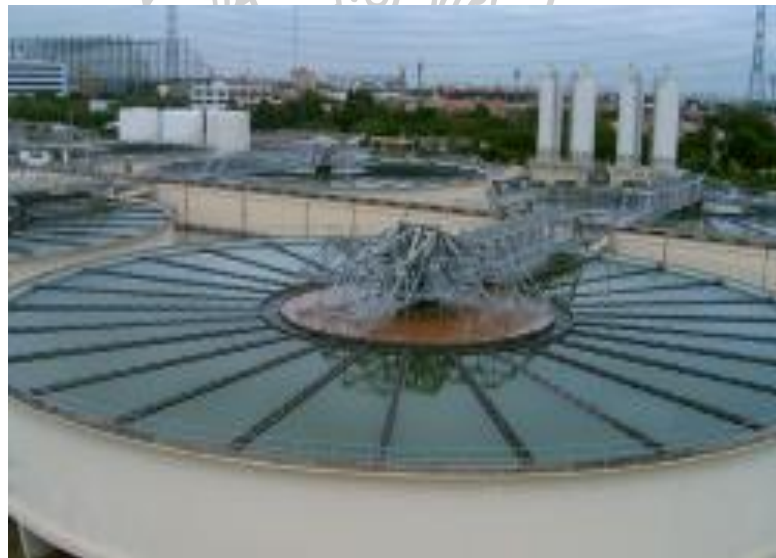
รูปที่ 3. 6 ถังตกตะกอนชนิดหมุนเวียนตะกอน
