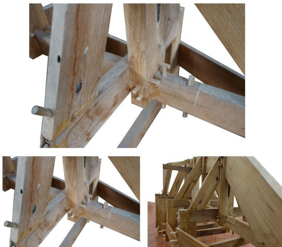
ภาพที่ 85 รายละเอียดจุดเชื่อมต่อของท่อน (คาน)
