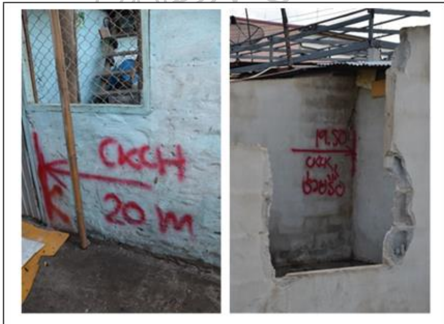
ภาพที่ 30 เครื่องหมายแสดงเขตแนวของการรื้อถอนที่ล้ำเข้าไปพื้นที่พักอาศัย ที่มา: ผู้ศึกษา
