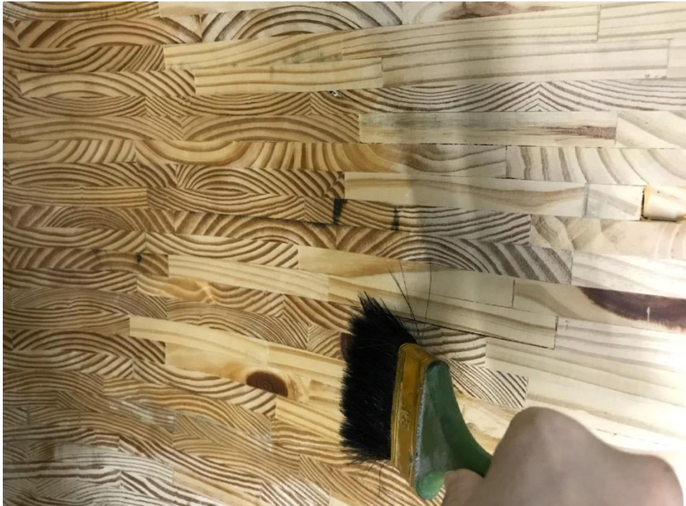
ภาพที่ 37 ภาพขั้นตอนการทำเคลือบน้ำยารักษาเนื้อไม้
