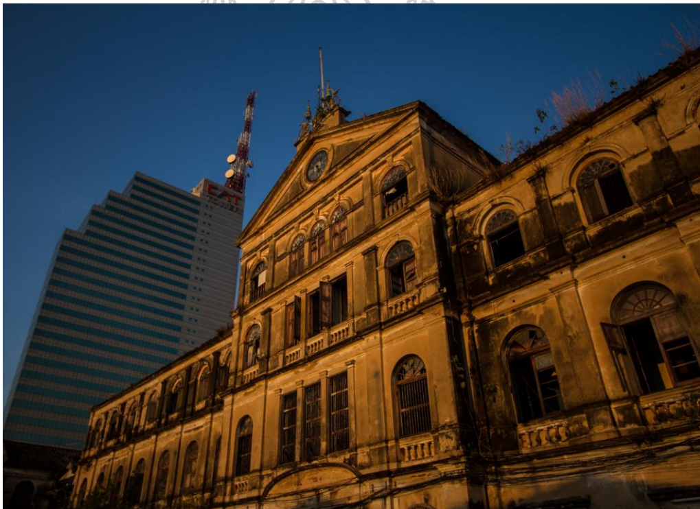
Figure 114 :อาคารสุลลสถาน เขตบางรัก กรุงเทพมหานคร
