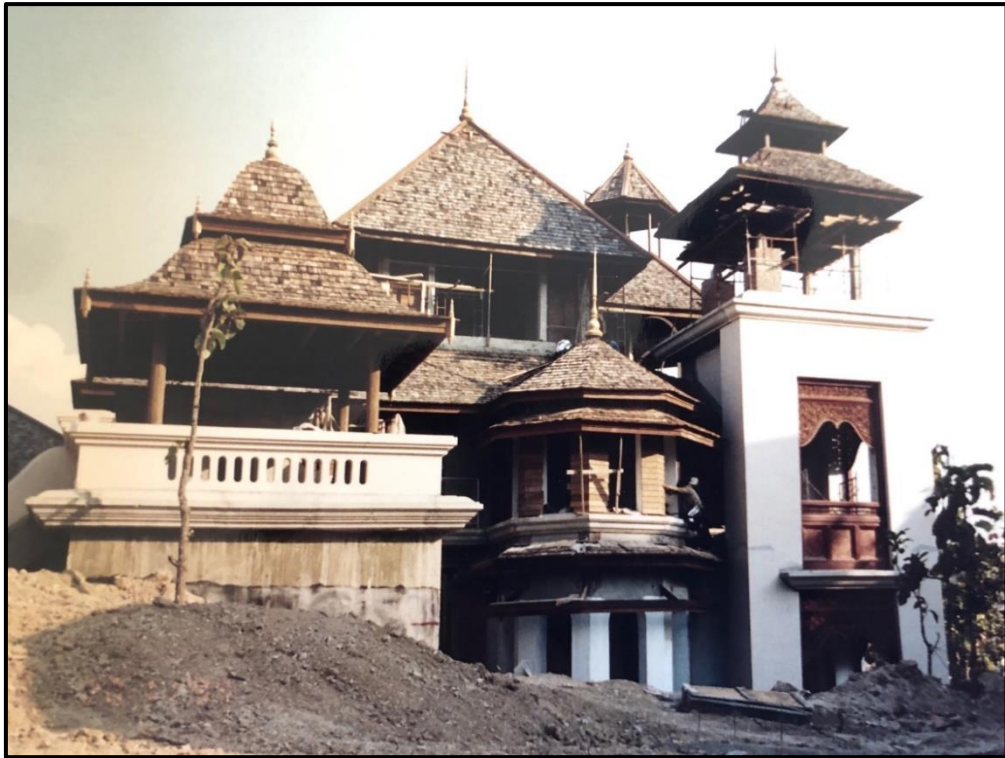
ภาพที่ 11 ภาพขณะก่อสร้าง เดอะ เรสซิเดนท โพรซีจันส์ เชียงใหม่ ที่มา: บริษัท บุนนาค อาร์คิเทคส์ อินเตอร์เนชั่นแนล คอนซัลแทนท์ส จำกัด
