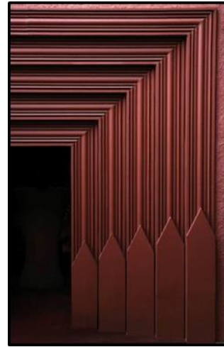
ภาพที่ 92 ลูกฟักกลางประกอบกรอบเขตหน้า ที่มา: บจก. บุนนาค อาร์คิเทคส์ ฯ
