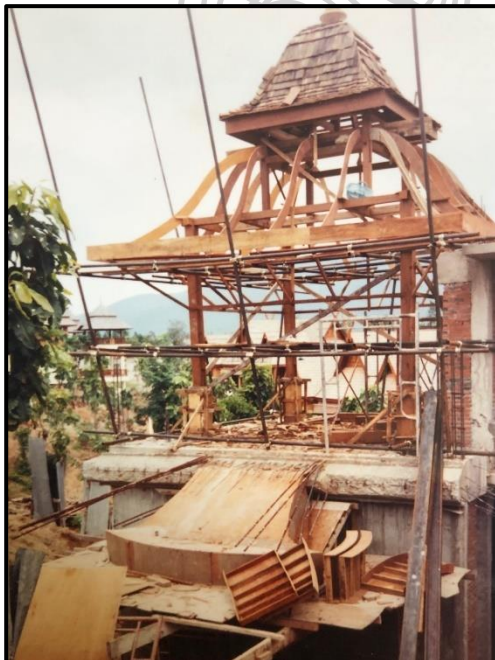
ภาพที่ 12 ภาพขณะก่อสร้าง ที่มา: บจก. บุนนาค อาร์คิเทคส์ ฯ
