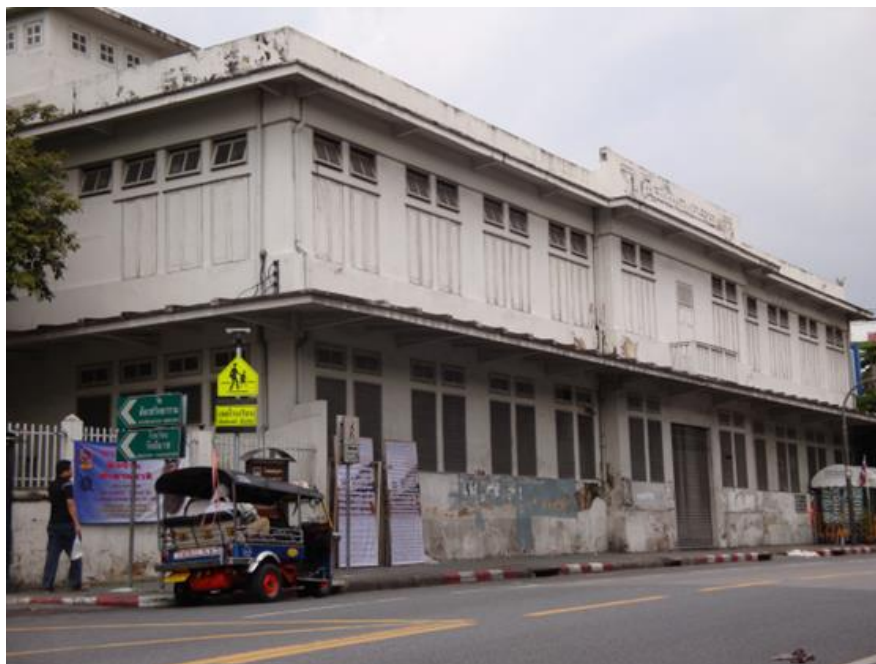
ภาพที่ 7 อาคารโรงเรียนช่างพิมพ์วัดสังเวช ก่อนการปรับปรุง ที่มา: https://wwisartsakul.wordpress.com/2009/10/19/897/
