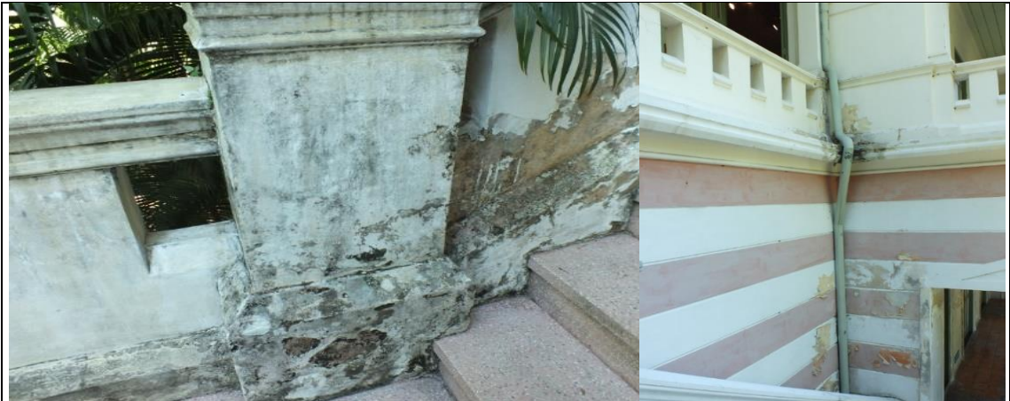
ภาพที่ 39 บริเวณที่อยู่ด้านนอกของอาคารพิพิธภัณฑสถานบ้านจิตเวชศาสตร์สมเด็จพระยา สาเหตุหลักอาจมาจากการเปลี่ยนแปลงของสภาพทางธรรมชาติ เช่น ฝน ลม แดด จนเกิดการผิผิวของสีภายนอกตัวอาคาร ตลอดจนทำให้เกิดตะไคร่น้ำในบางส่วน ที่มาภาพ: ผู้ศึกษา 11 มิถุนายน พ.ศ. 2558
