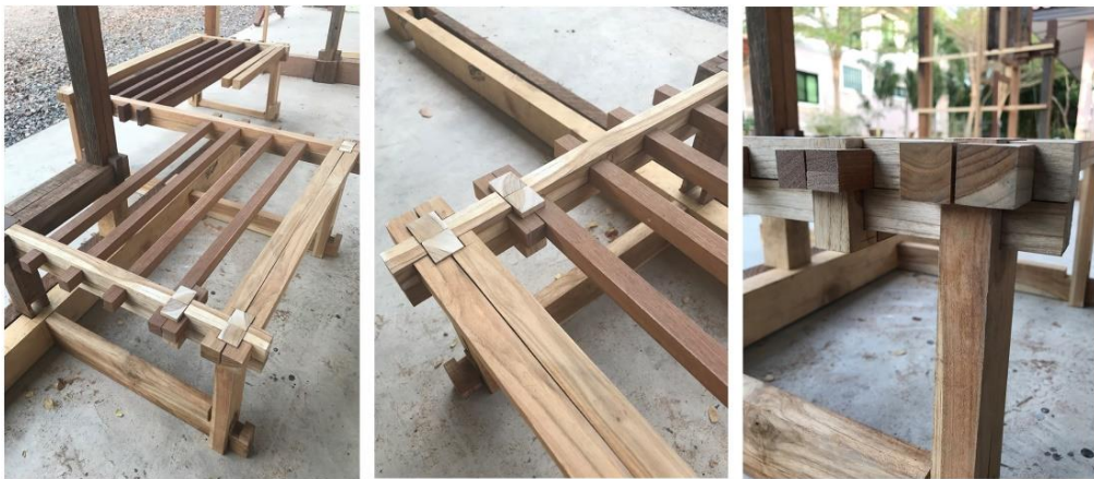
ภาพที่ 130 ภาพเทคนิคการเข้าไม้จริง (17) ถ่ายโดย : ธนพล หมอกยา
