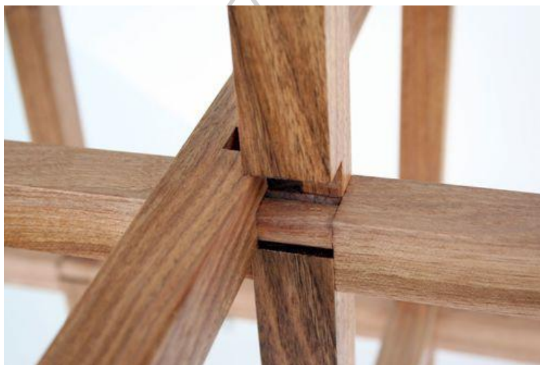
ภาพที่ 19 ผลงานการต่อไม้แบบชิโดริ (Chidori) ของ Kengo Kuma ที่มา : Lischka Cuin, เข้าถึงเมื่อ 12 กุมภาพันธ์ 2562 เข้าถึงได้จาก https://www.pinterest.es/pin/308285536974066080/
