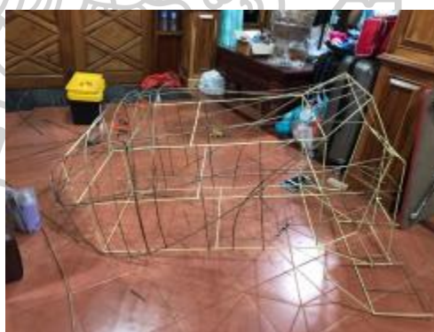
รูปภาพที่ 51 การขึ้นโครงไม้
