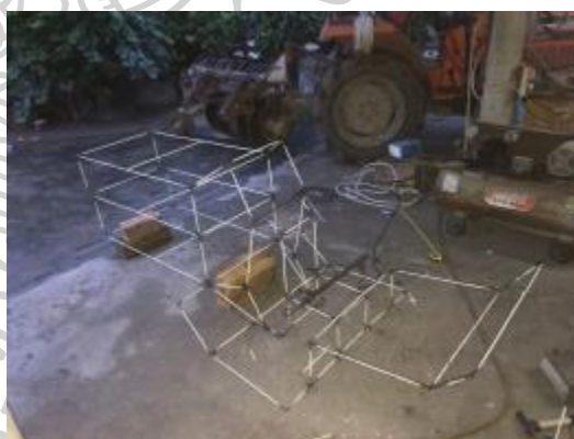
รูปภาพที่ 49 การขึ้นโครง
