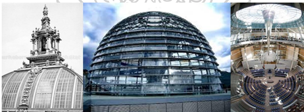
ภาพที่ 28 หลังคาอาคารเดิมและปัจจุบันที่ถูกปรับปรุงแล้วโดย Sir Norman Foster ที่มา Architect in Competition และ Ga Document Extra 12
