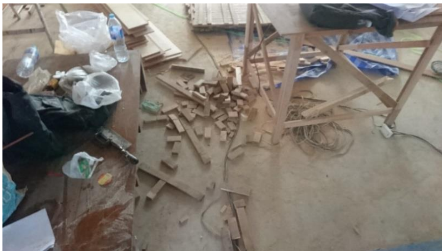
ภาพที่ 23 : ตัวอย่างเศษวัสดุจากการก่อสร้างตกแต่งภายในจากสาเหตุการตัดชิ้นวัสดุเพื่อให้ได้ขนาดที่ต้องการ
