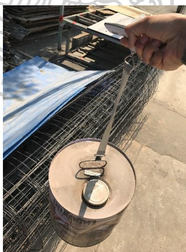
ภาพที่ 26 : การชั่งน้ำหนักวัสดุที่เหลือจากการก่อสร้างตกแต่งภายในจากสาเหตุจัดซื้อวัสดุผิดพลาด
