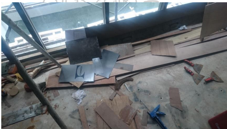
ภาพที่ 24 : ตัวอย่างเศษวัสดุจากการก่อสร้างตกแต่งภายในจากสาเหตุการตัดชิ้นวัสดุเพื่อให้ได้ขนาดที่ต้องการ
