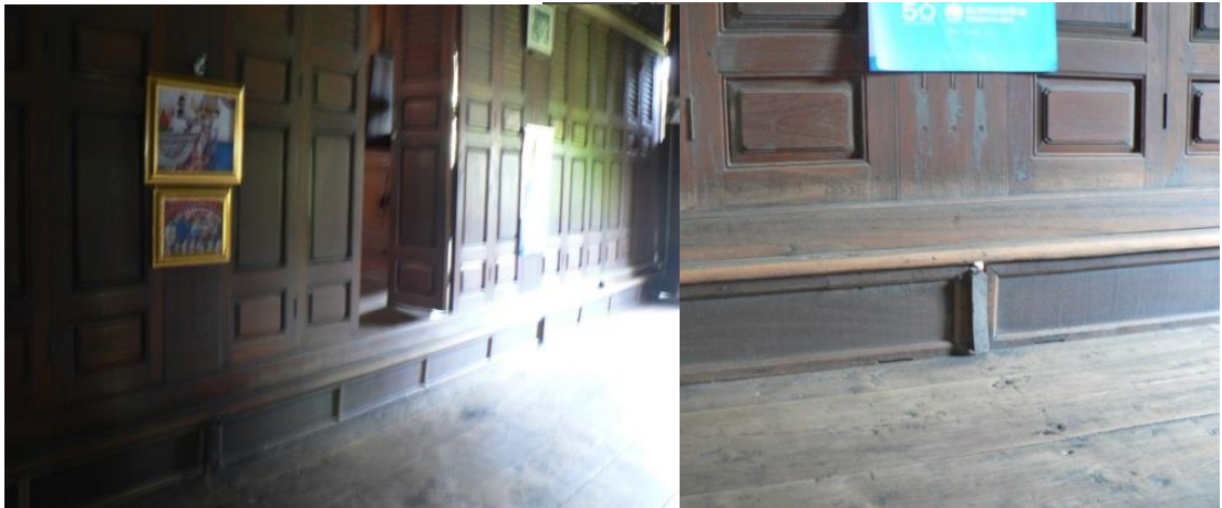
ภาพที่ 94 ช่องแมวลอดที่ในอดีตเปิดปิดได้ แต่ปัจจุบันปิดถาวรเพื่อความปลอดภัย
