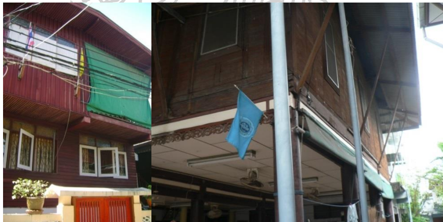
ภาพที่ 35 การการติดตั้งกันสาดผ้าใบที่ใต้ถุนและระเบียง เพื่อกันแดดกันฝน
