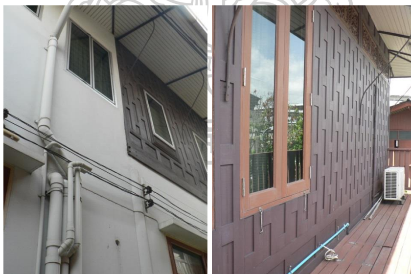
ภาพที่ 110 การใช้ผนังลูกฟักเรือนเดิมและผนังที่สร้างเลียนแบบภายนอกเรือนกรณีศึกษาที่ 6
