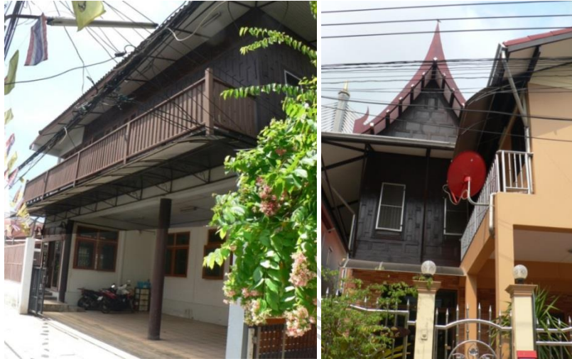
ภาพที่ 34 เรือนไทยมอญทรงคองที่มีการปรับปรุงเรือนบางส่วนเป็นอาคารคอนกรีต
