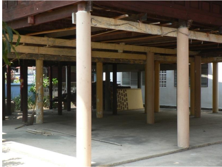
ภาพที่ 88 แสดงใต้ถุนโล่ง และเสาไม้ของเรือนที่วางบนเสาคอนกรีต
