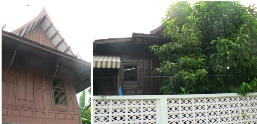
ภาพที่ 30 รูปแบบเรือนเดิมที่ผนังเป็นลูกฟูกกระดานดุน หน้าต่างมีกรอบซี่ดหน้า
