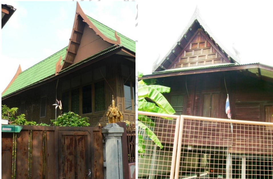
ภาพที่ 31 เรือนมอญหน้าจั่วเหงา หลังคามุงกระเบื้องลูกฟูก มีค้ำยันเหล็กเส้นโค้ง
