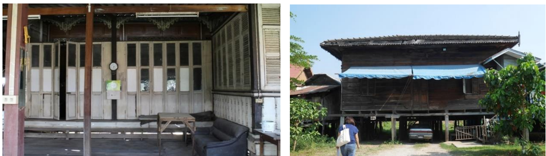
รูปที่ 157 แสดงประตูทางเข้าห้องนอน (ซ้าย) และสภาพภายนอกอาคาร (ขวา)
