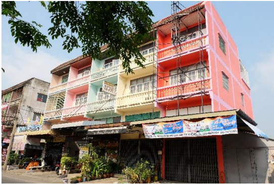
อาคารตึกแถวย่านหลักสี่
