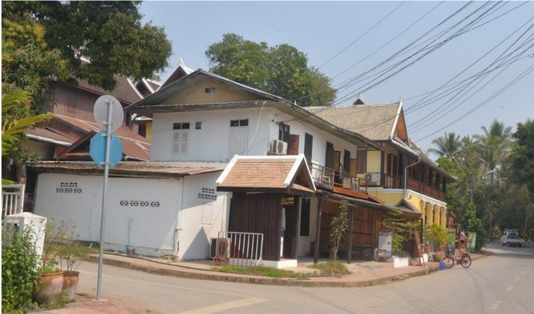
ภาพที่ 155: อาคารที่พักอาศัยบนถนนแค่มคานเขตวัดเชียงใหม่
