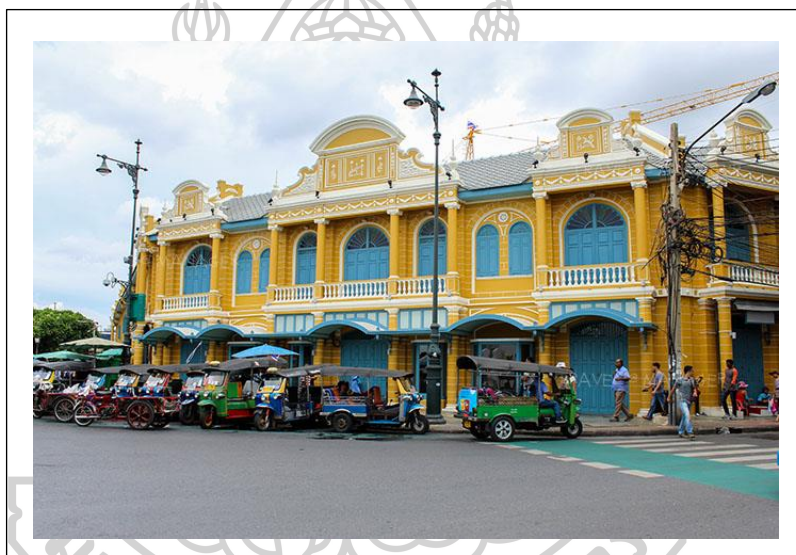
ภาพที่ 4 โครงการปรับปรุงฟื้นฟูอาคารอนุรักษ์บริเวณท่าช้างวังหลวง ที่มา : https://mgronline.com/travel/detail/9590000055683
