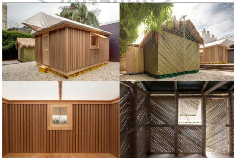
ภาพที่ 18 แสดงความแตกต่างของวัสดุผนังและหลังคาPaper Log House
