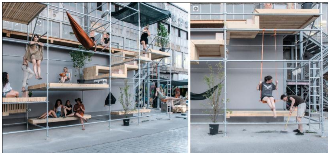
ภาพที่ 2 แสดงการใช้งานโครงสร้างชั่วคราว
