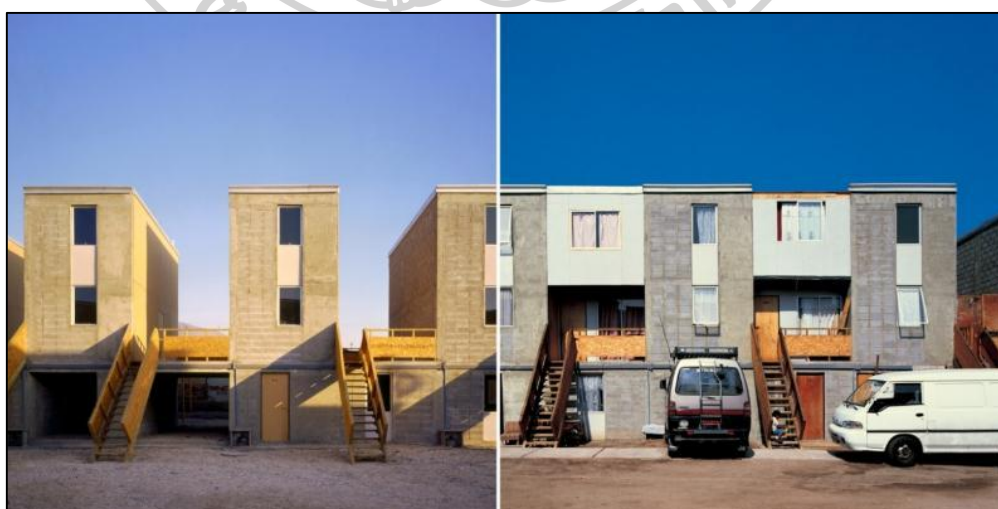
ภาพที่ 22 แสดงโครงการ Quinta Monroy ก่อนและหลังการต่อขยาย
