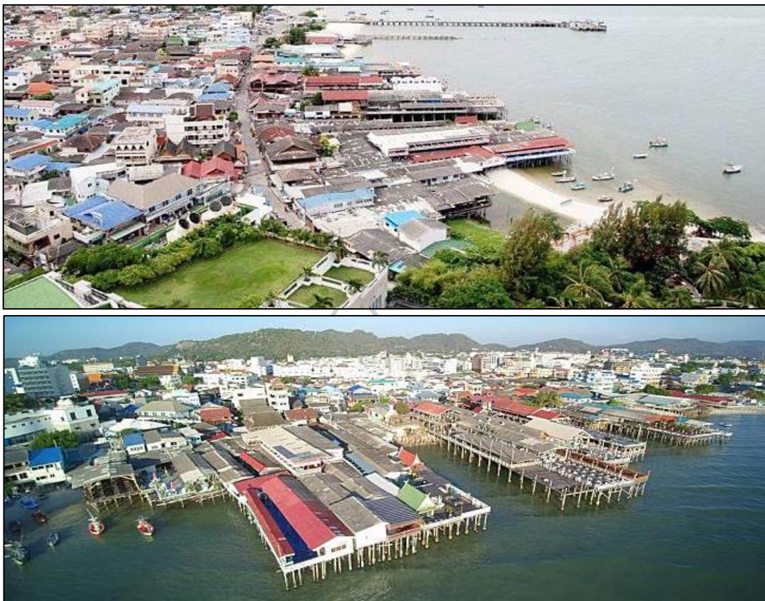
ภาพที่ 62 การก่อสร้างอาคารและสิ่งปลูกสร้างวางทางน้ำ ทางระบายที่จะไหลลงทะเลในเขต ฝั่งเมืองรวมหัวหิน ที่มา: https://today.line.me/th/pc/article/
