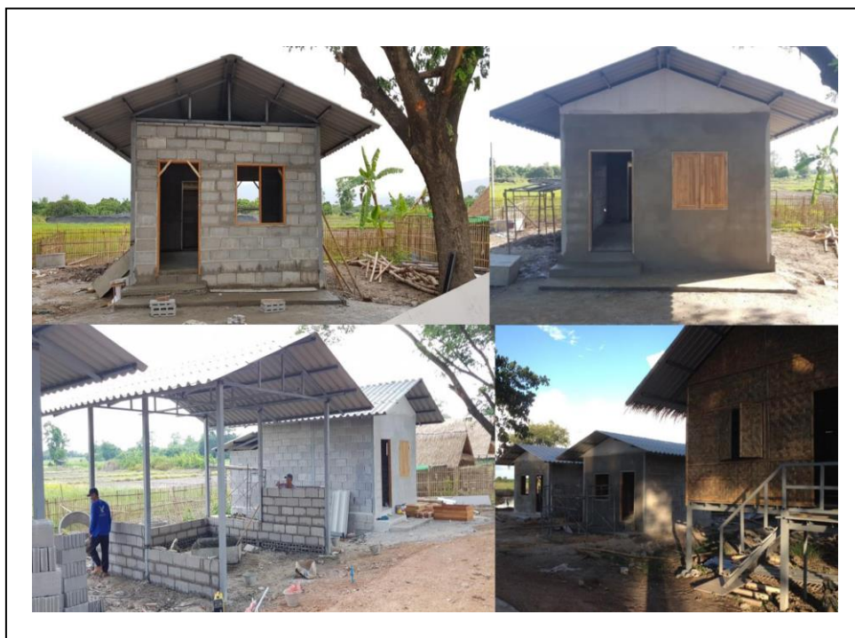
ภาพการก่อสร้างบ้านมั่นคงชนบทที่พื้นที่สาธารณะ
