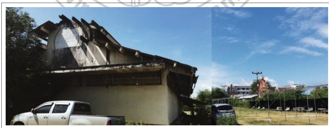
ภาพที่ 40 อาคารคลังน้ำมันทิ้งร้างของการรถไฟและพื้นที่เปิดโล่งขนาดใหญ่
