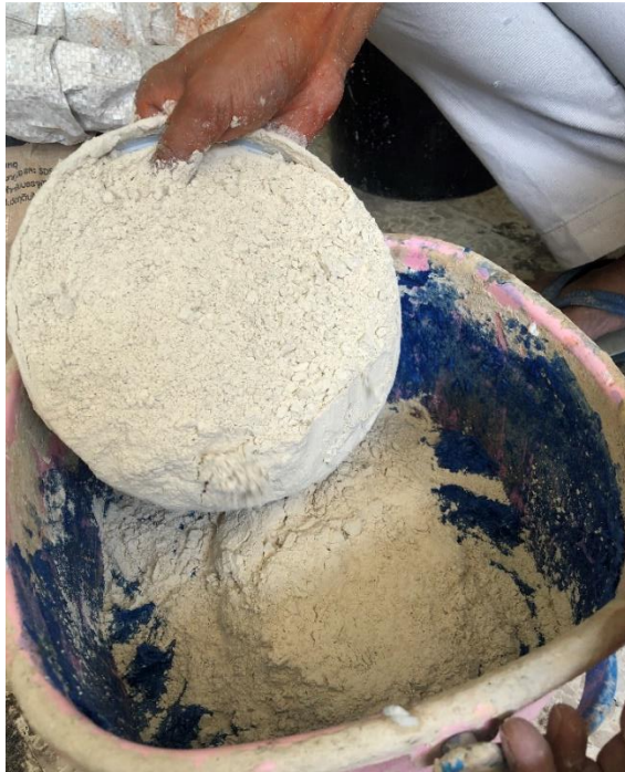
ภาพที่ 65 ขั้นตอนการเทดินสอพองผสมลงไป
