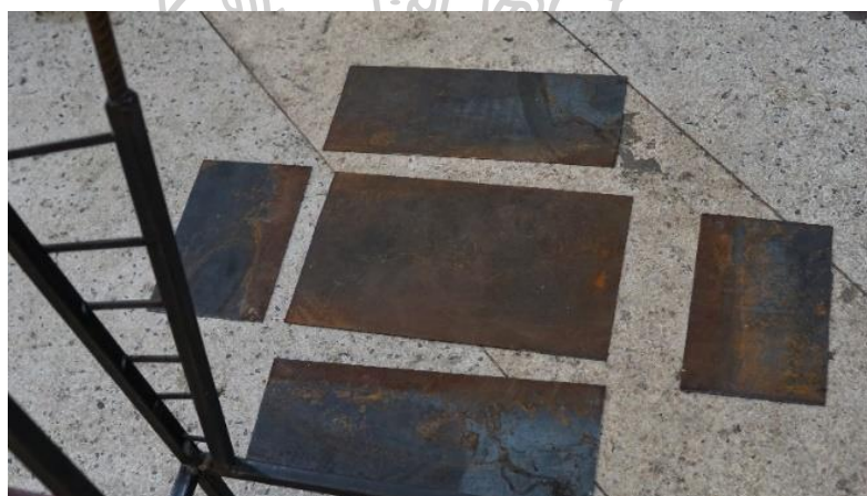
ภาพที่ 62 ขั้นตอนการขึ้นโครงสร้างด้วยเหล็ก
