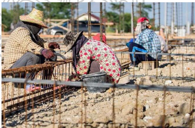
ภาพที่ 7 ภาพอริยาบถของคนนั่งกำลังผูกเหล็กโครงสร้าง ภาพจาก https://baabin.com/general/26767
